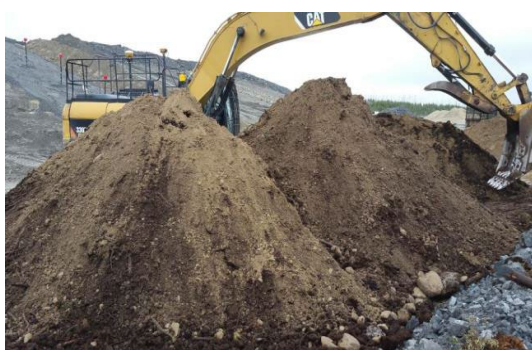
i) Fabrication du mélange mort-terrain/tourbe
