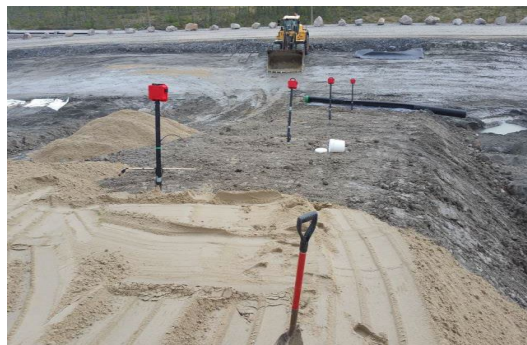
h) Mise en place de la couche de sable sur la cellule ELCP-1
