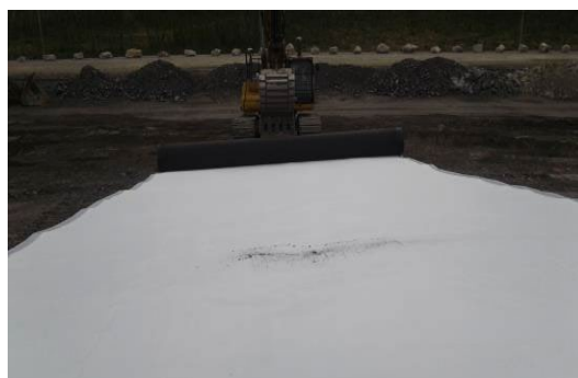
d) Installation des géomembranes sur les cellules
