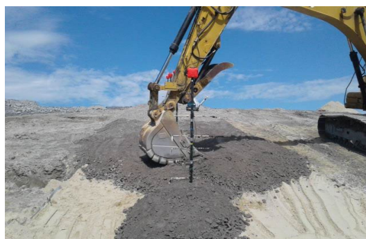
f) Mise en place de la couche de stériles miniers
