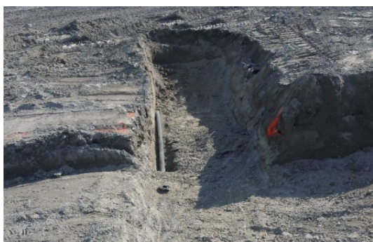
c) Installation des drains de collecte
