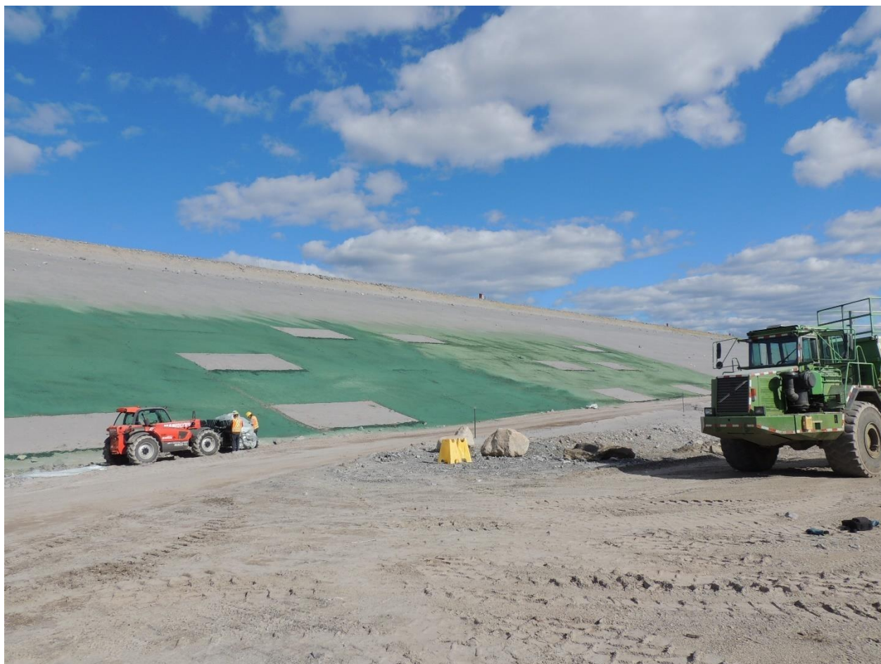
Figure 3-6 Hydrosemoir utilisé (droite) lors de l'ensemencement des parcelles expérimentales les 13 et 14 août 2022.
