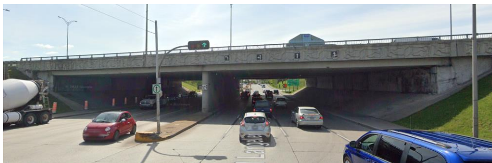
Figure 1.1 Exemple de pont urbain à Montréal
