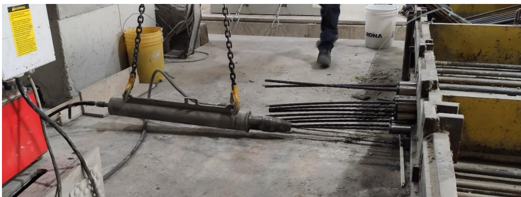
Figure 2.14 Mise en tension des torons à l'usine BPDR
