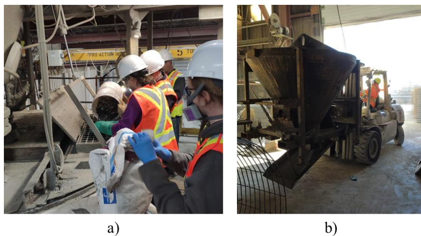
Figure 4.3 Production du BFHP, a) Introduction des fibres dans le malaxeur, b) Transport de la gâchée de béton
