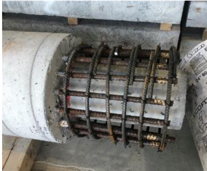
Figure 4.8 Mise en place des étriers dans le joint (P5)
