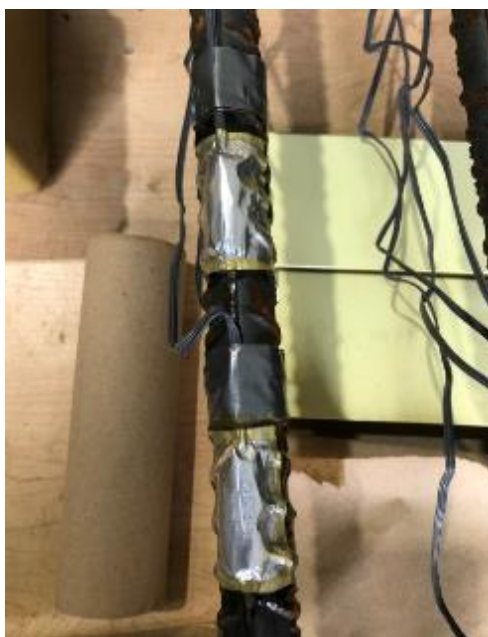
Figure 4.37 Jauges collée – après protection
