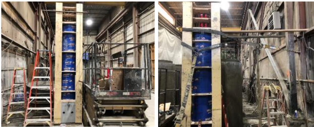
Figure 4.2 Montage pour la coulée du fût (P5)
