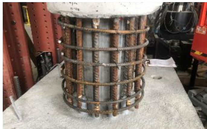
Figure 4.9 Joint dans la zone de chevauchement – avant la coulée (P5)
