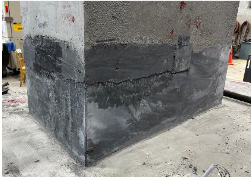
Figure 5.17 Joint après réparation
