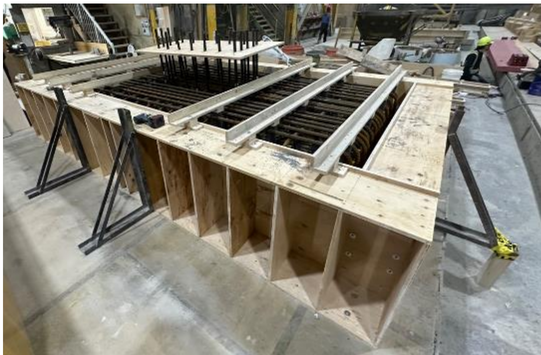
Figure 5.2 Coffrage de la semelle
