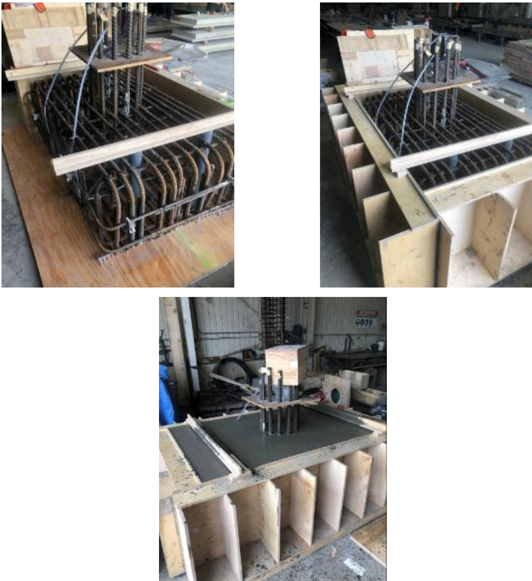
Figure 4.5 Fabrication de la semelle (P5)
