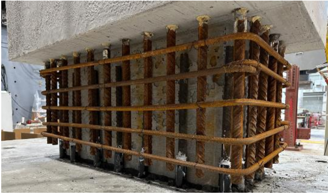
Figure 5.8 Joint de chevauchement avec la coulée du BFUP
