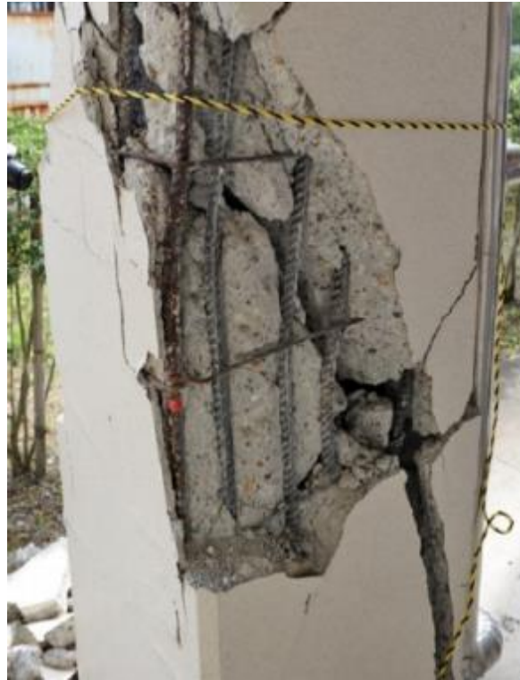
Figure 2.9 Rupture en cisaillement (Swanson, 2011)
