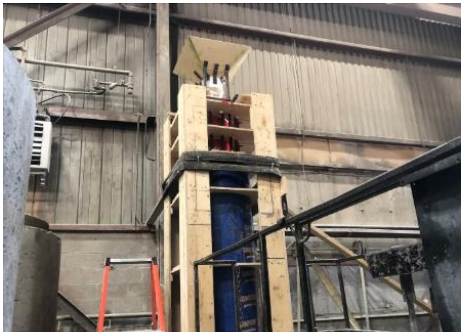
Figure 4.3 Trompe pour la coulée du fût (P5)
