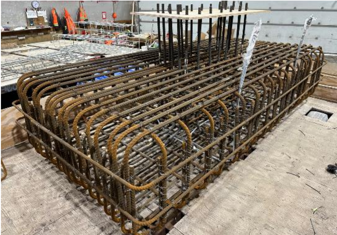
Figure 5.1 Cage d'armatures de la semelle
