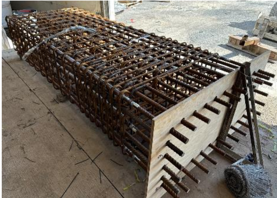
Figure 5.4 Cage d'armature du fût
