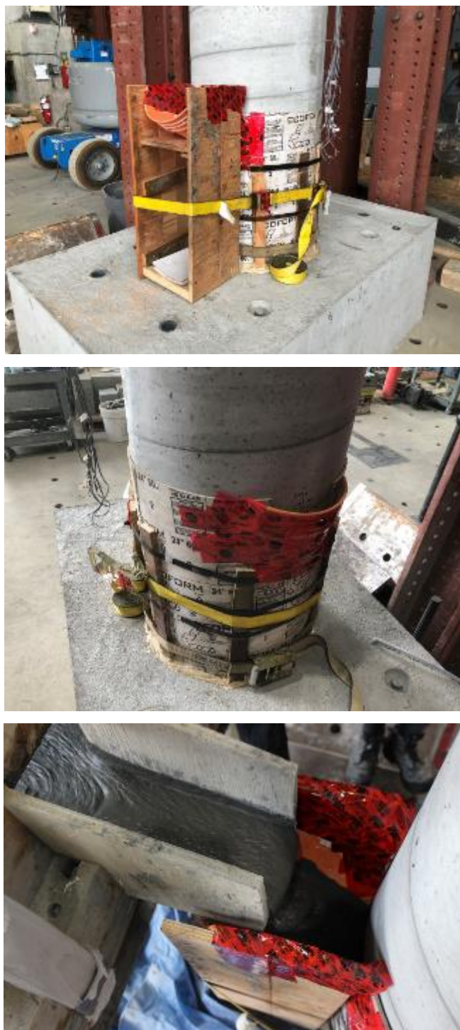
Figure 4.11 Coffrage utilisé pour la coulée du joint (P5)
