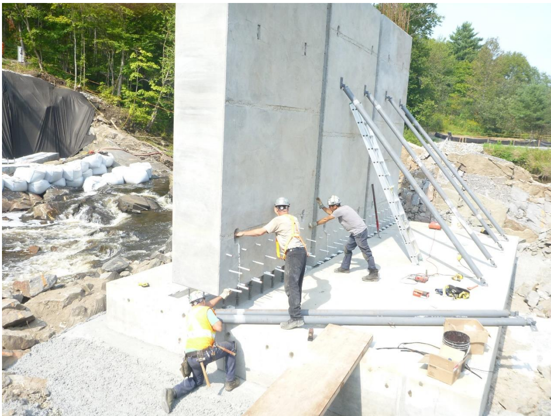
Figure 2.13 Principe de construction accélérée (MTQ)
