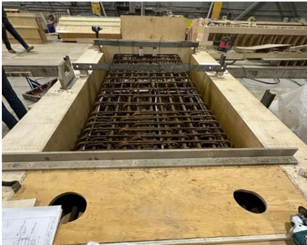
Figure 5.5 Coffrage pour le fût
