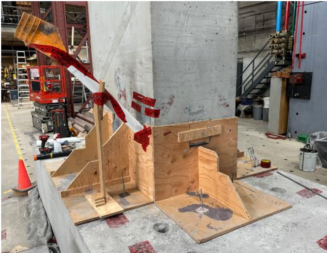
Figure 5.16 Coffrage pour couler la réparation du joint
