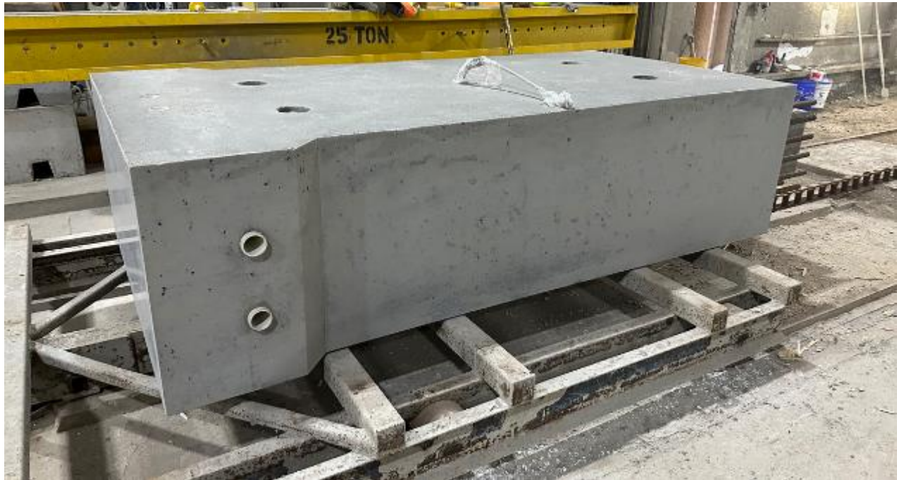
Figure 5.6 Semelle juste après décoffrage
