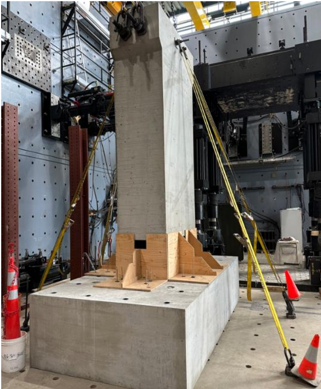
Figure 5.10 Coffrage pour couler le joint en BFUP
