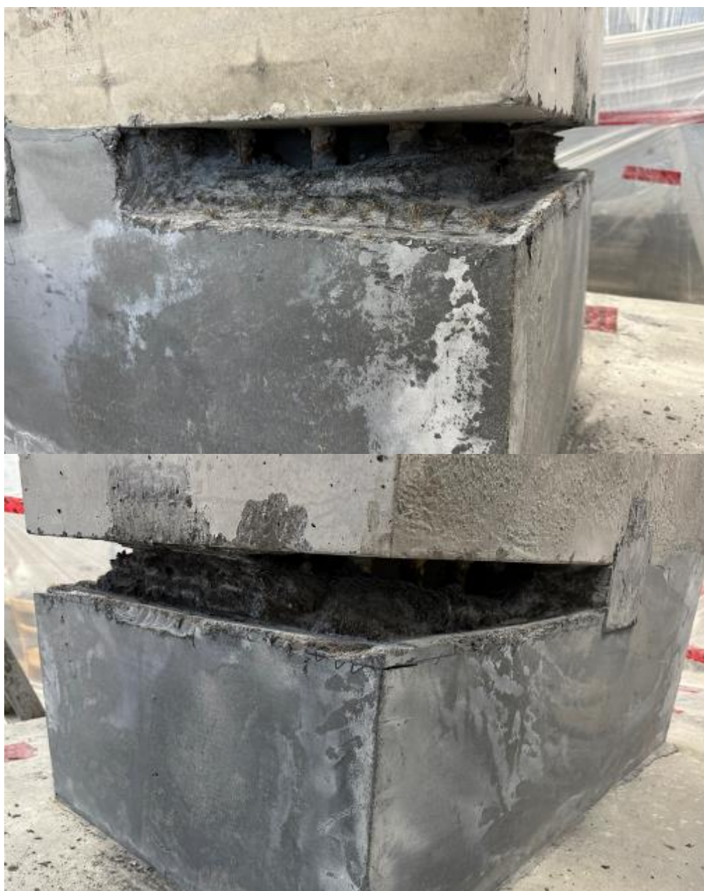
Figure 5.15 Surface après préparation pour la réparation du joint
