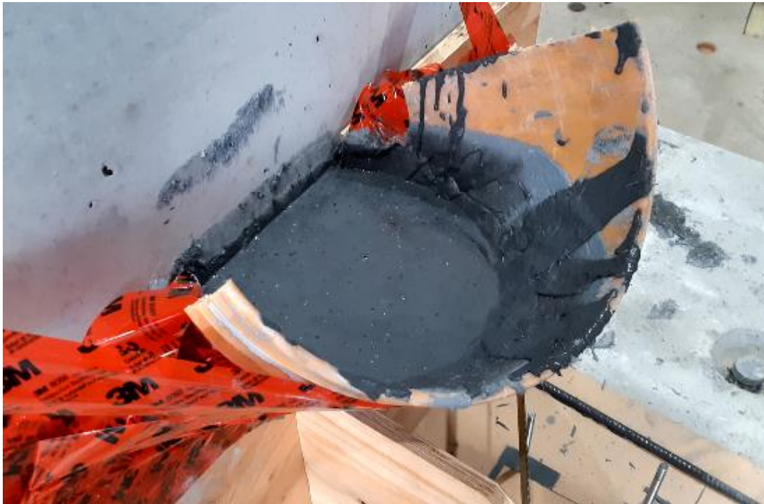
Figure 5.12 Point d'entrée de BFUP rempli
