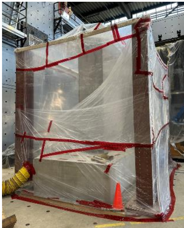
Figure 5.14 Enceinte pour préparation de surface – réparation du joint
