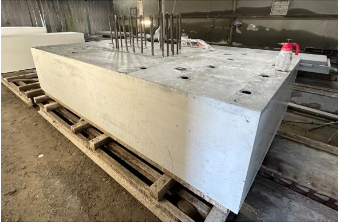
Figure 5.3 Semelle juste après décoffrage
