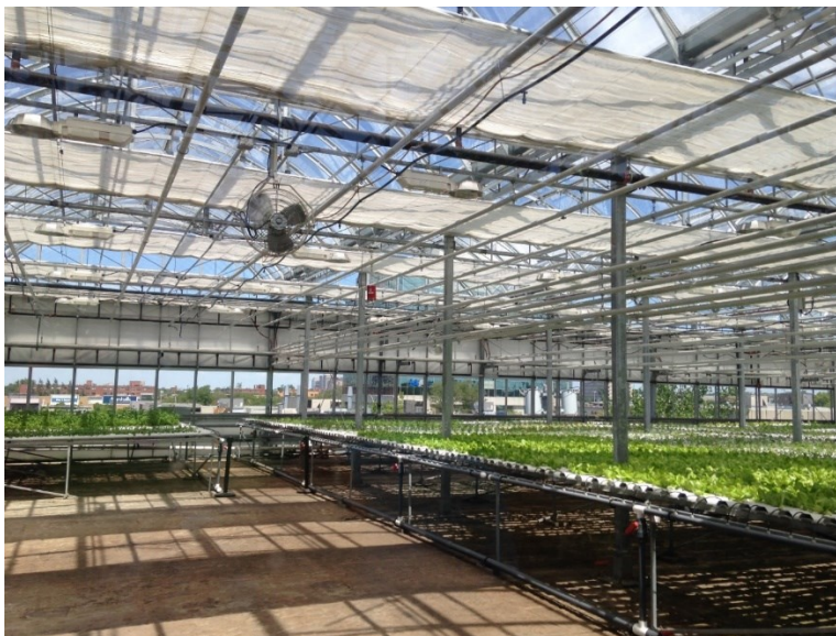
Figure B.6.7 Système de culture hydroponique horizontal dans la zone froide pour les légumes feuilles.
