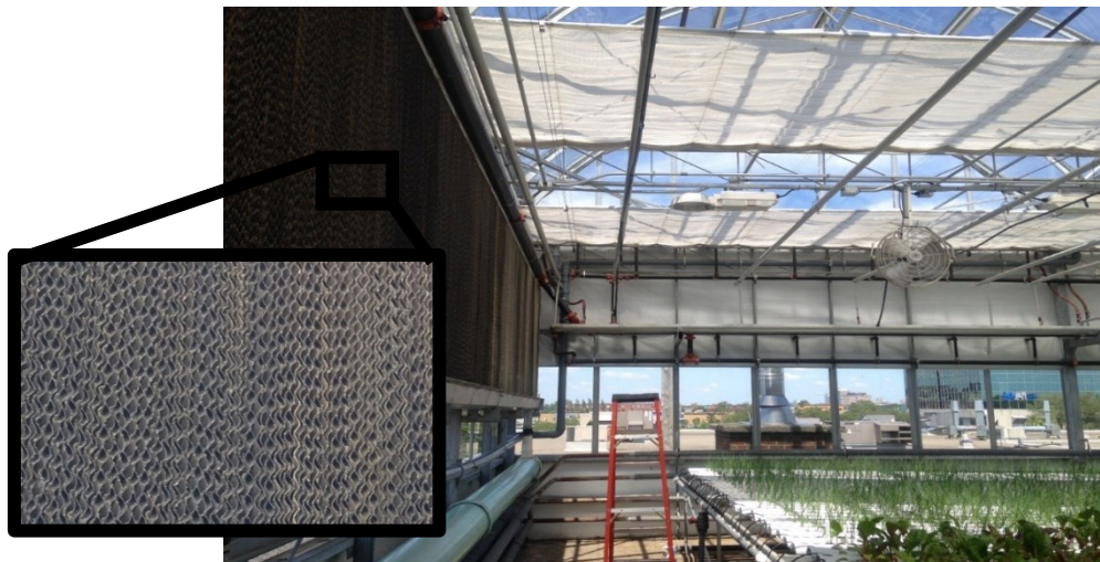
Figure B.6.8 Système de refroidissement par évaporation appelé cooling pad .
