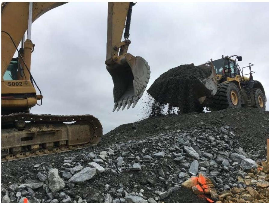
Photo E-12 : Mise en œuvre de la troisième couche de stériles miniers 0/800 mm (+1.00 à +1.50m)
