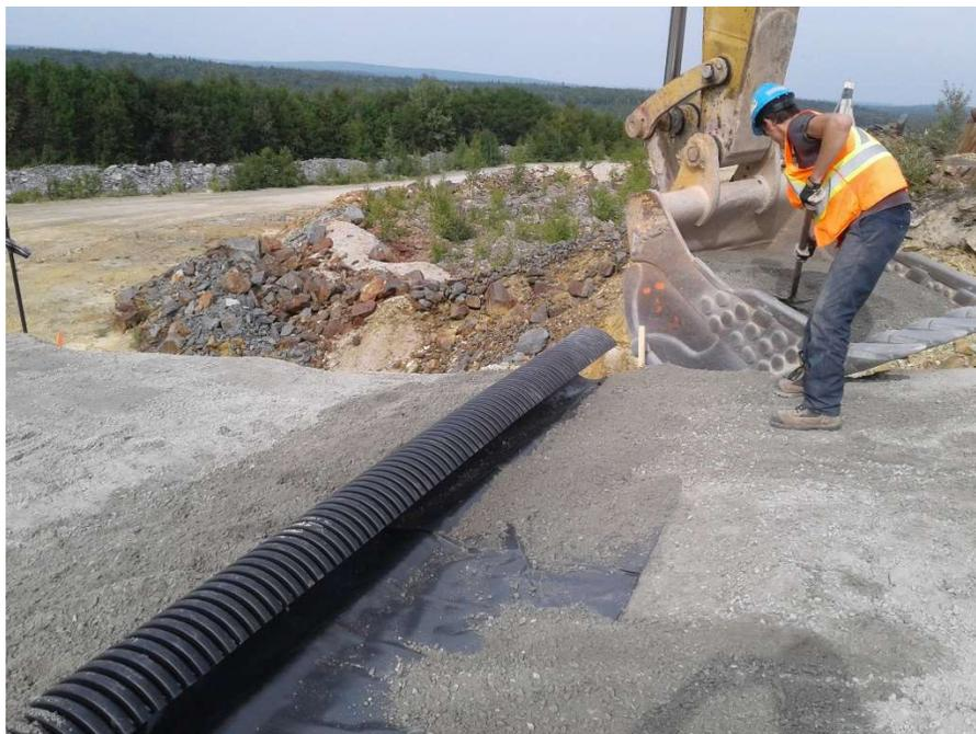
Photo B-3 : Mise en place du drain de collecte des eaux de ruissellement en bas de la pente de 20% (Août 2018)
