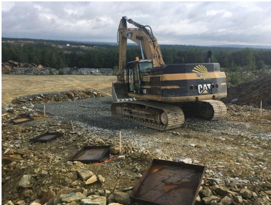
Photo E-8: Épandage et nivellement de la couche de réglage pour obtenir les côtes aux niveaux de la PST.
