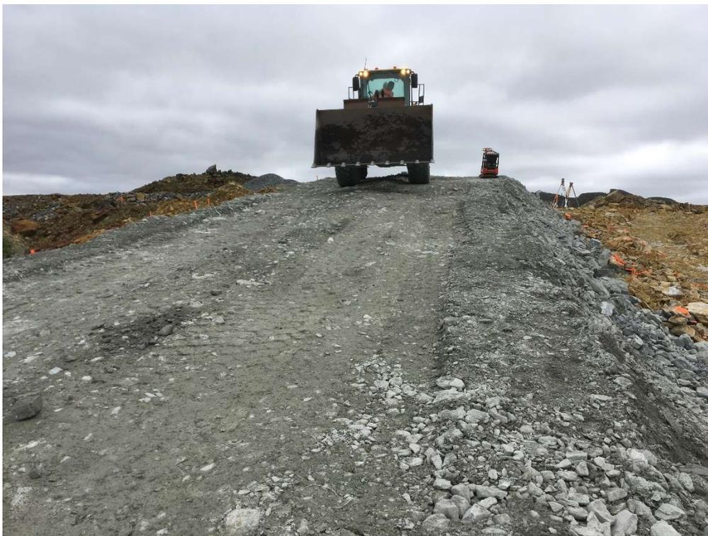
Figure 4-9 : Opération de compactage lors de construction des couches de stériles miniers 0/800 mm.
