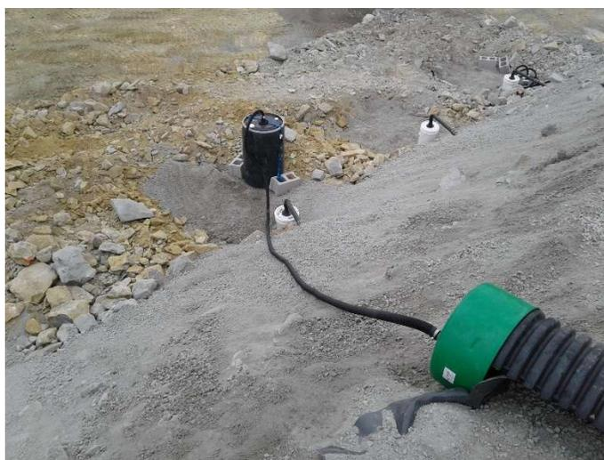
Photo B-2 : Connection du drain au premier modèle de cuve de stockage (Août 2018)
