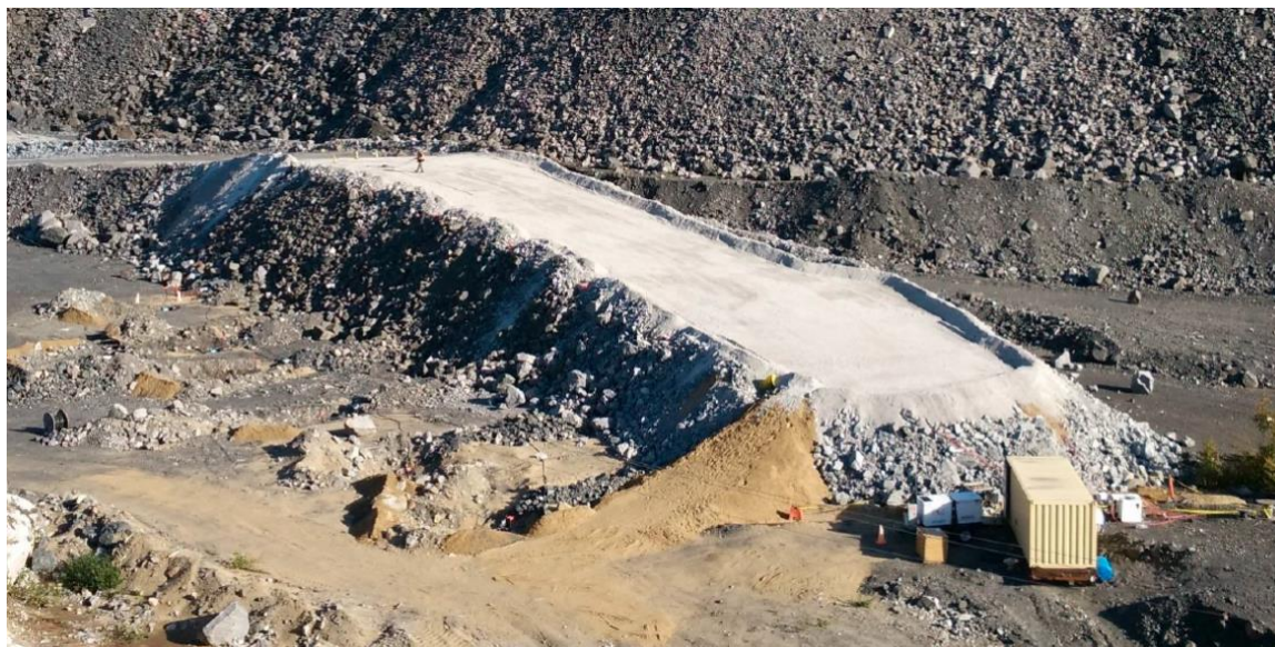
Figure 2.8 : Halde expérimentale de la mine du lac Tio (crédit IRME). Les roches stériles sont recouvertes de matériaux fins dont le sable formant la couche de contrôle des écoulements et l'anorthosite concassée visible en gris clair. La pente est de 5%. La surface de la halde possède une berme sur le pourtour.
