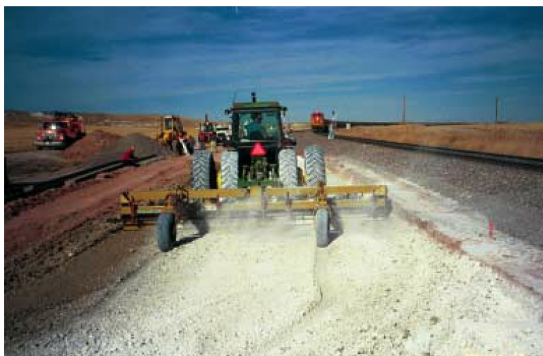
Figure 2.20 – Stabilisation du sol avec chaux pour la construction de routes (Hyslip & McCarthy, 2000)
