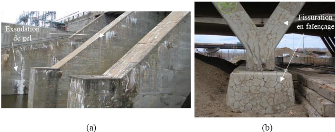
Figure 2.6 : Exemples d'ouvrages affectés par la RAS : (a) Aménagement hydraulique à l'étude dans ce projet (b) Pile de pont à Québec (Sanchez et al., 2020)
