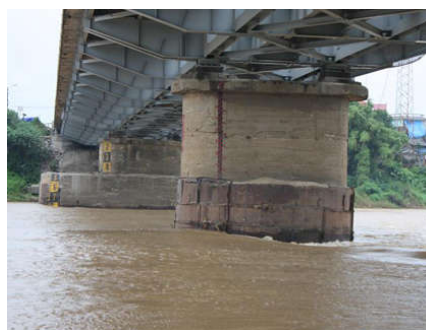
(d) Pilier de pont ayant subi un impact de bateau
