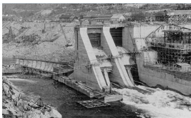
(b) Piliers en cours de construction
