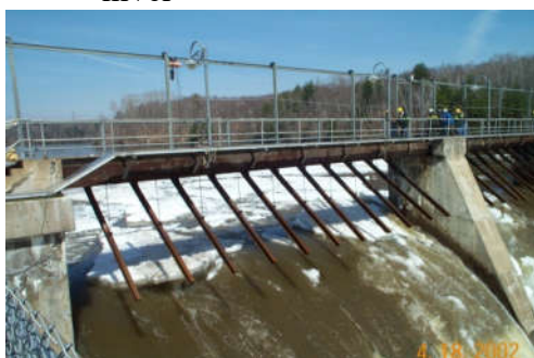
(c) Piliers d'évacuateur de crues avec effets d'impact de glace
