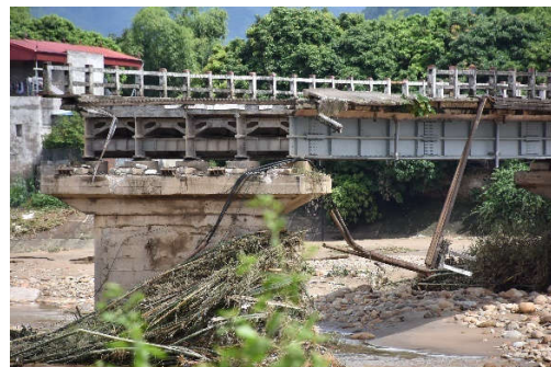
(f) Pilier de pont avec impact de débris flottants
