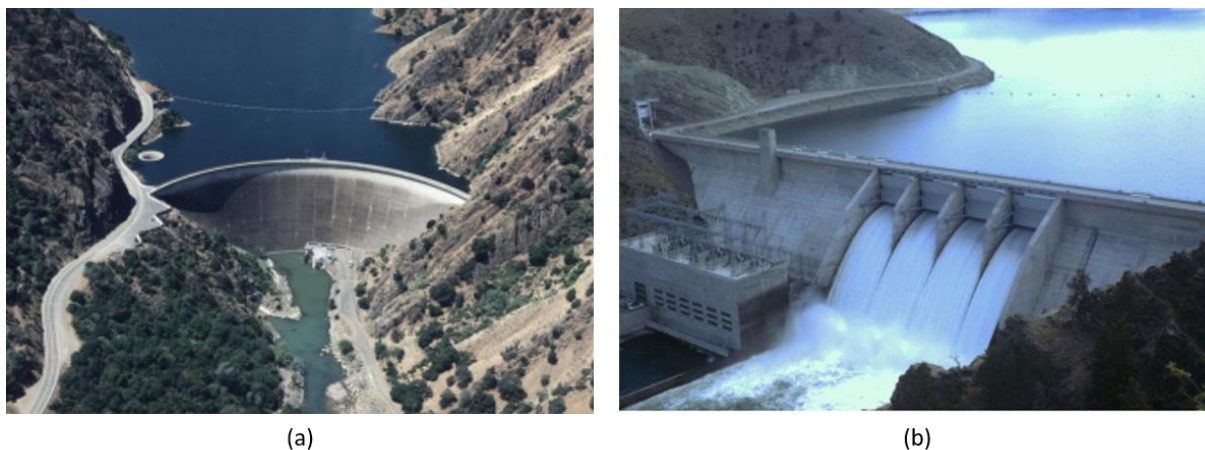
Figure 2.2 Photographies du Barrage voute de Monticello (a) et du barrage poids de Canyon Ferry (b) (USBR, 2013)
