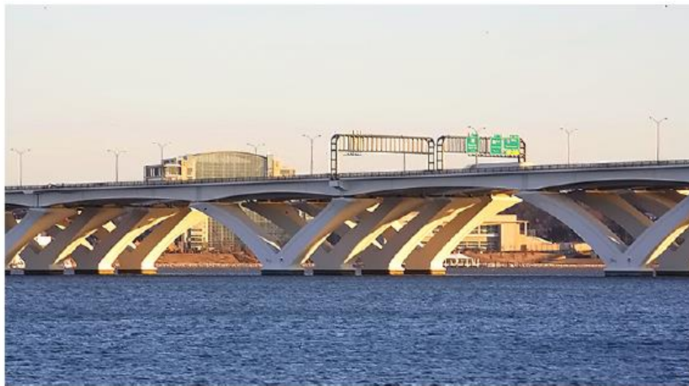
Figure 2.3 Pont avec piles préfabriquées en arcs ouverts selon (Massicotte et al., 2011)
