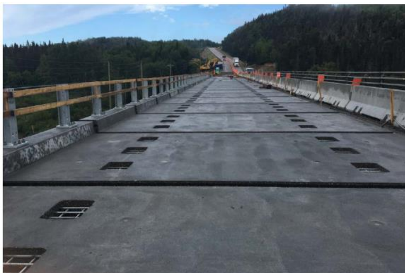
Figure 2.7 Dalles préfabriquées installées du Pont Godbout (Gill-Lachance, 2019)
