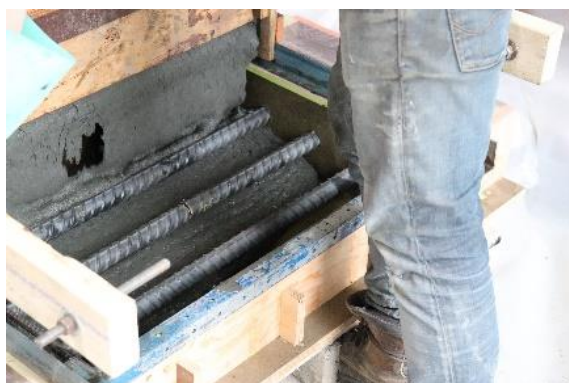
c) Étape 1 : écoulement du BFUP
