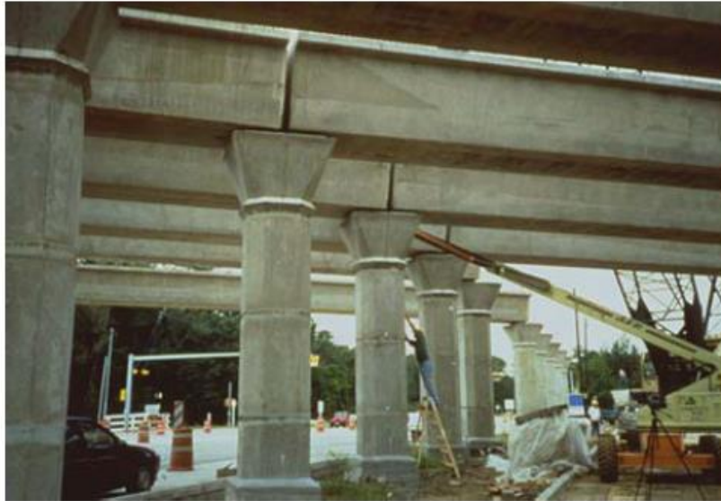
Figure 2.2 Pont à pile en colonnes préfabriquées, TX (PCI, 2005) selon (Massicotte, Rochon-Massicotte, & Conciatori, 2011)
