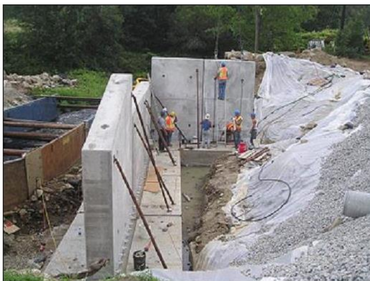
Figure 2.1 Modules de culée préfabriqués verticaux, pont d'Epping (Stamnas & Whittermore, 2005) selon (Oliva, Unlu, & Okumus, 2011)
