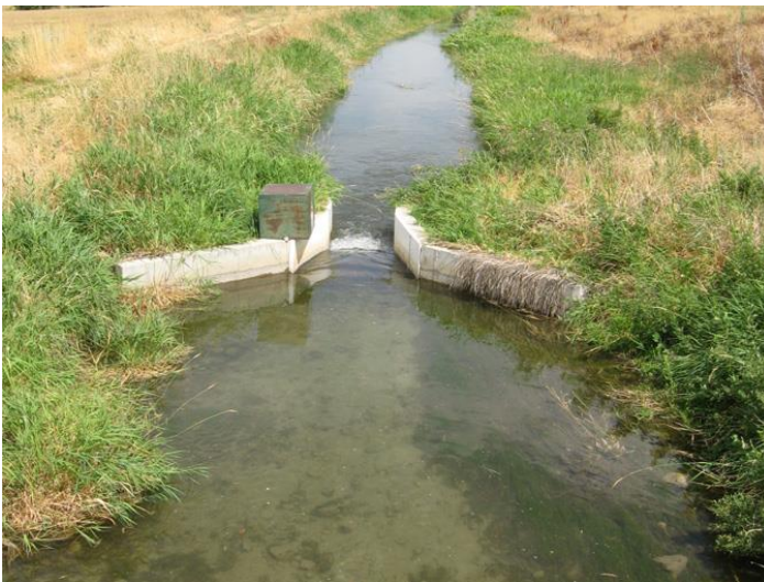
Figure 2.6 Exemple de canal jaugeur installé dans un fossé (tiré de Tullis & barfuss, 2009)
