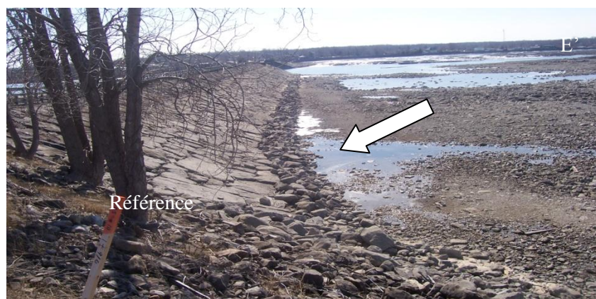
Figure 4.12: Fuite d'eau visible en Amont du barrage St-Timothée (Réservoir vidé)
