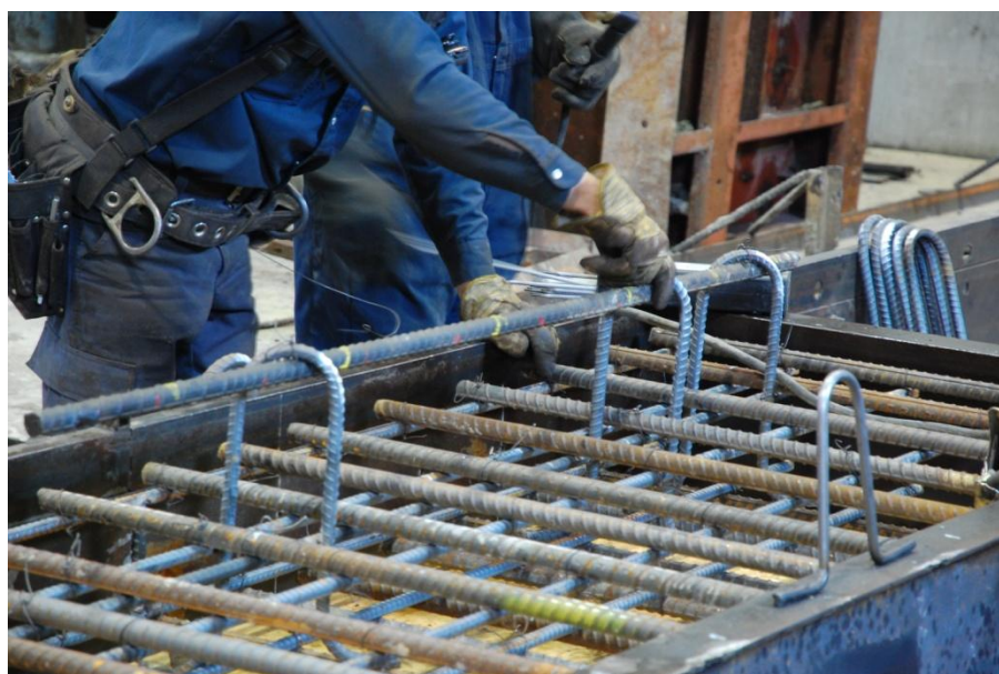
Figure 4-2- Alignement des ancrages en U
