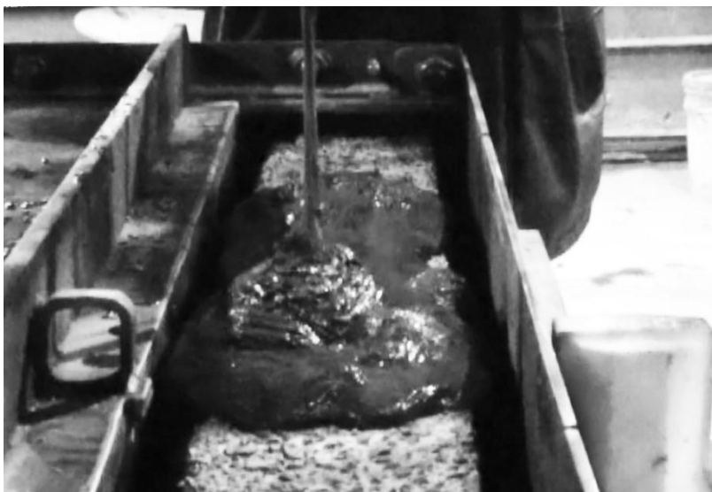
Figure 4-8 - Coulé du BRF120MPa-4% de la coque du parapet hybride.
