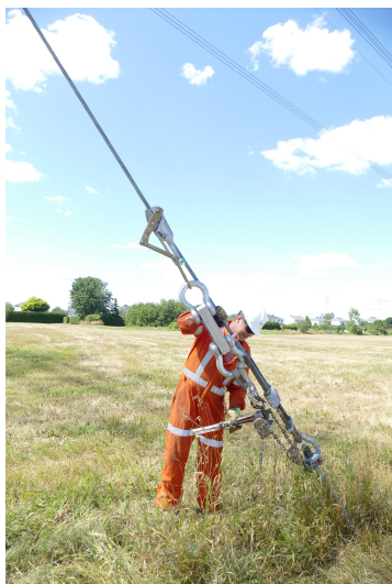
Figure C.3 Installation du dynamomètre - Photographie Najib Bouaanani
