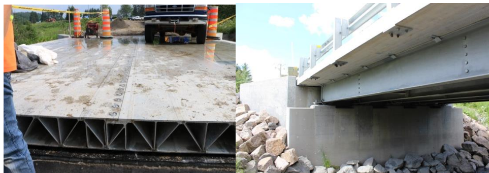
Figure 2.15 : Exemple d'un platelage longitudinal en aluminium (Gracieuseté, Centre de recherche sur l'aluminium - REGAL)
