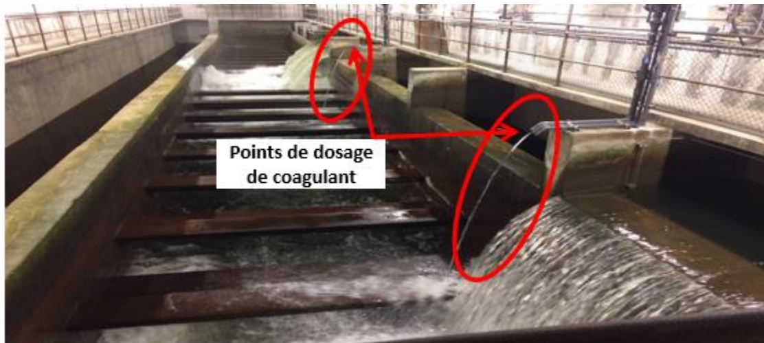
Figure 3.4 Points d'injection de coagulant à l'usine.
