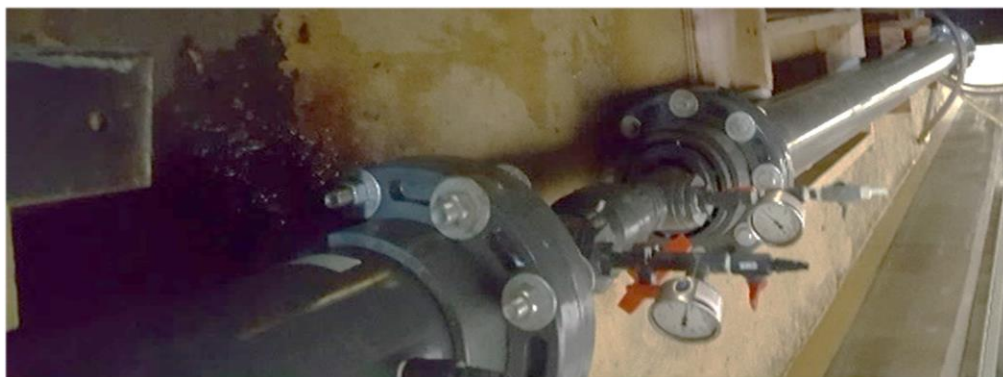
Figure 3.6 Photo du flocculateur hydraulique
