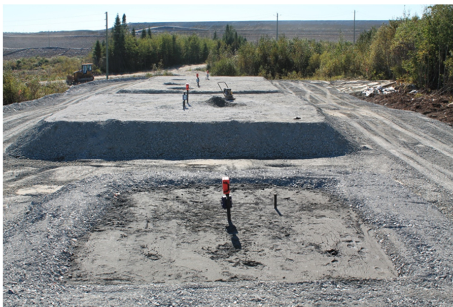
Figure 3-40 : Vue sur les cellules finalisées (CRT-1 au premier plan, suivi de CR-4 (paste rock), et CR-2, la CR-3 est plus basse au fond)
