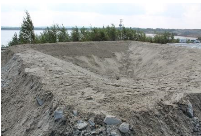
Figure 3-33 : Mise en place de la couche de sable dans la cellule CR-4
