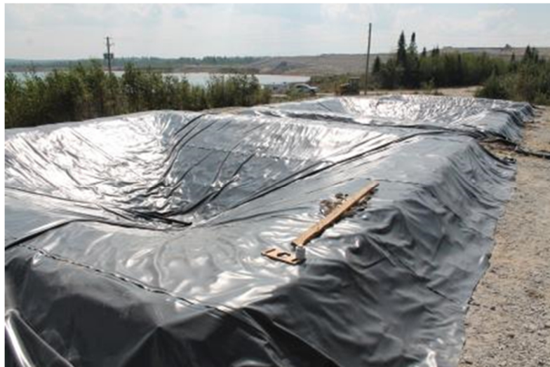
Figure 3-34 : Mise en place des géomembranes dans cellules CR-2, CR-3, CR-4 (la plus près)
