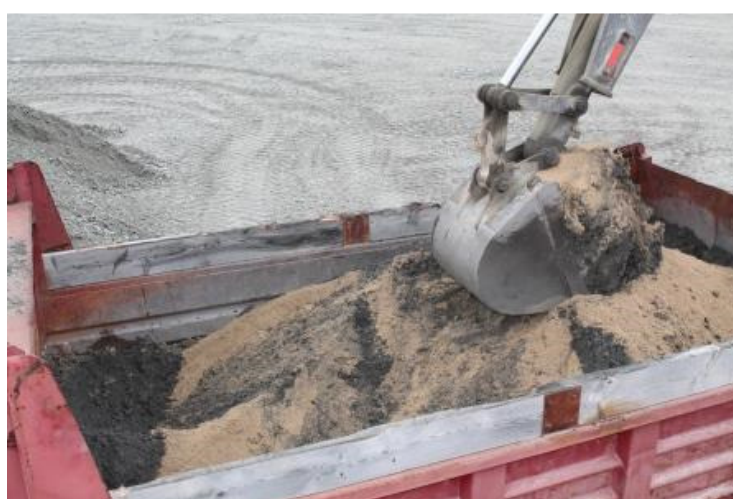
Figure 3-30 : Préparation du mélange du paste rock à la mine LaRonde
