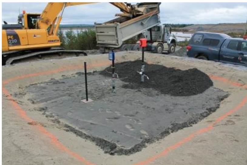
Figure 3-38 : Mise en place du paste rock dans la cellule CR-4
