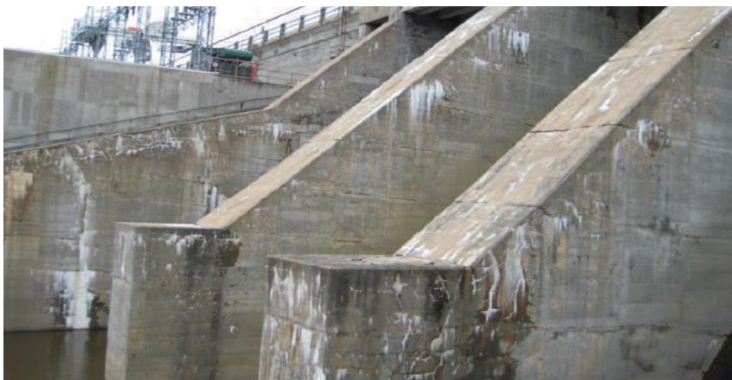
Figure 2.6 : Évacuateur complémentaire de l'aménagement présentant des signes de RAG
