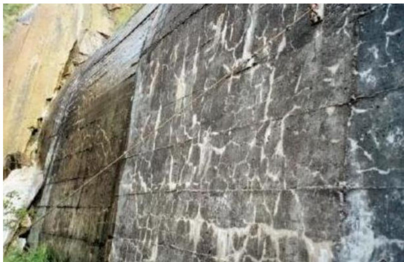
Figure 2.3 : Fissuration en faïençage et gel blanchâtre caractéristique de la RAG (tirée de Lesquereux (2006))
