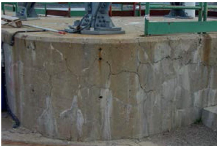
Figure 2.4 : Fissuration du béton au barrage de Mactaquac en 2008 (tirée de Poole et Sims (2016))
