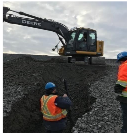
Figure 4.16 : Tranchée effectuée dans le recouvrement d'une des cellules
