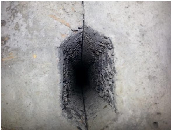
(b) Clé de connexion longitudinale
