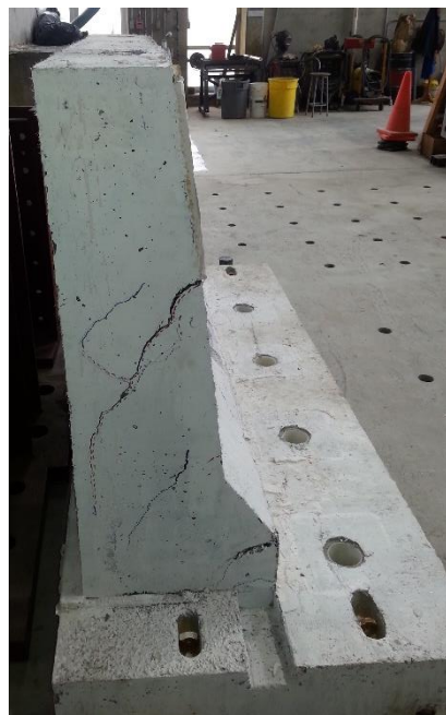
(a) Côté du parapet
