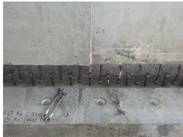
(c) Barres dans la niche de connexion
