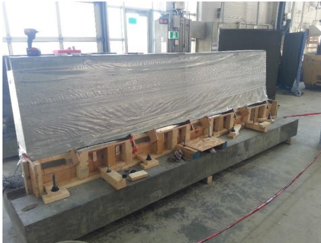
(a) Coffrage de la niche
