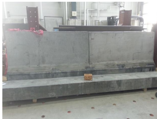
(c) Deux Parapet MTQ301 préfabriqués installés sur la dalle de pont
