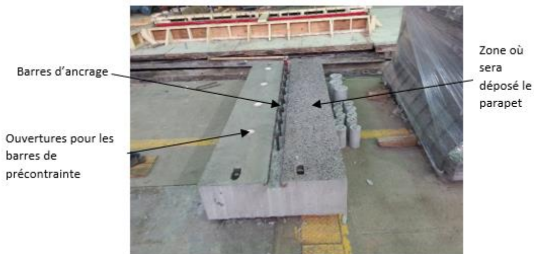
Figure 4.7 - Dalle de pont de 2,4 m
