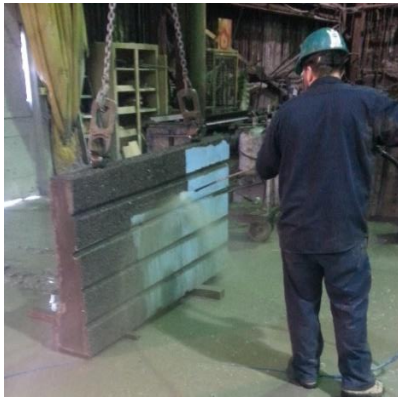
(a) Nettoyage de la surface
