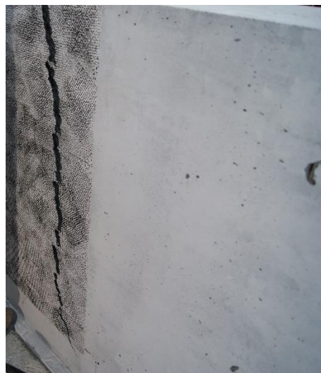
(b) vue à l'arrière du parapet non chargé
