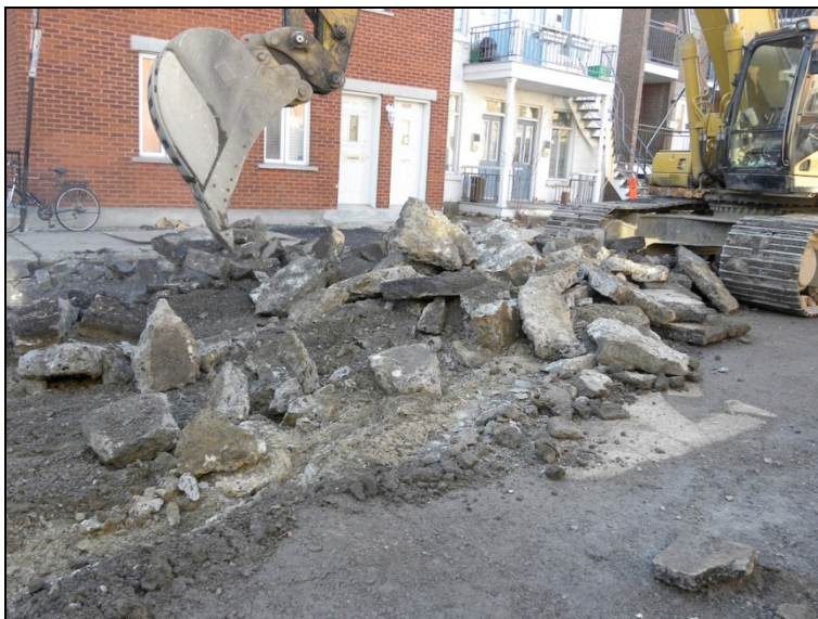
Figure 6-19: Photo de la dalle de béton et de la couche d'asphalte en train d'être enlevées.
