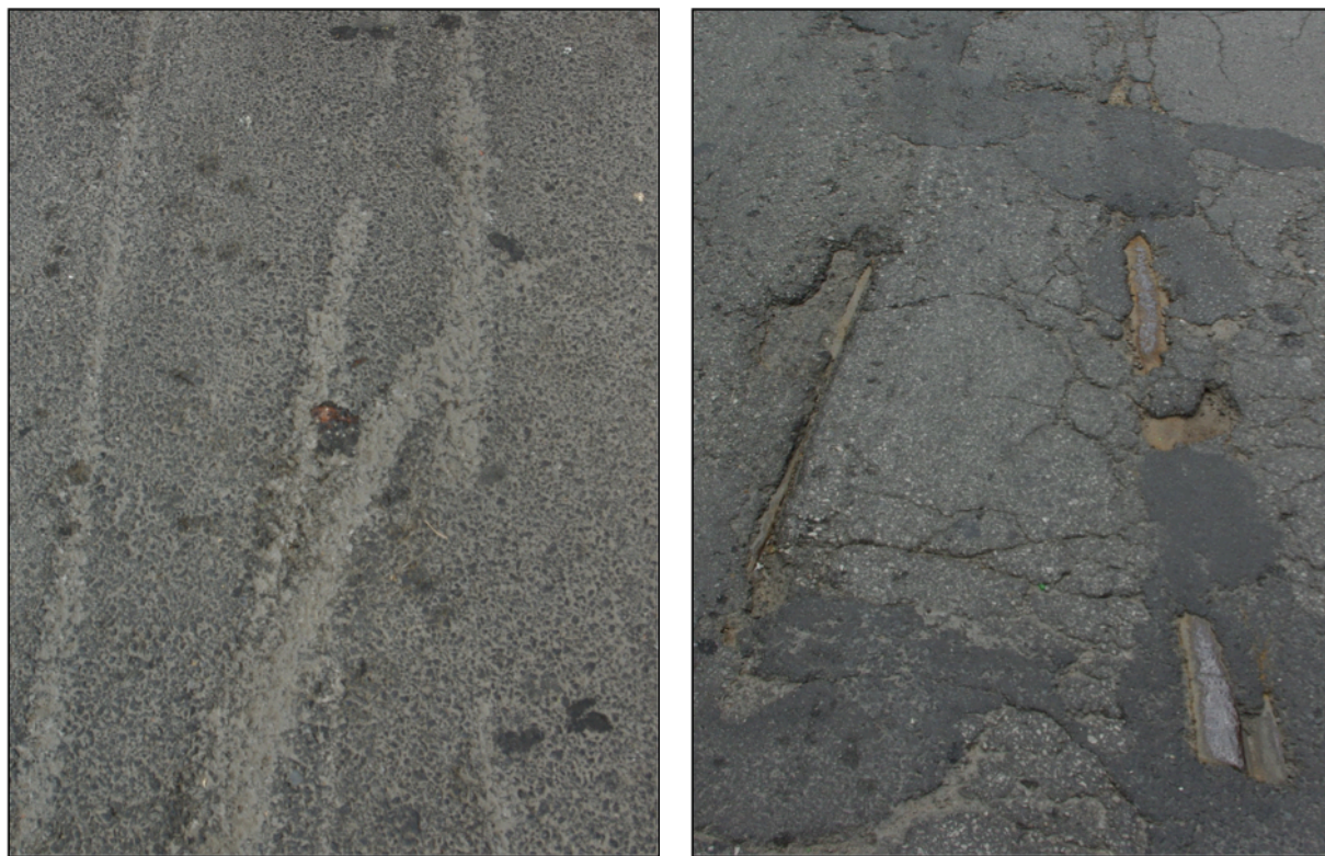
Figure 3-13: Défauts divers. Traces de chasse-neige à gauche et anciens rails de tramway enfouis à droite.
