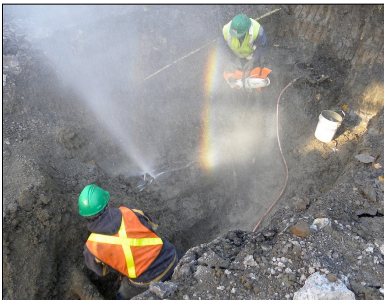
Figure 6-21: Conduite d'eau particulière percée lors de travaux dans une tranchée.
