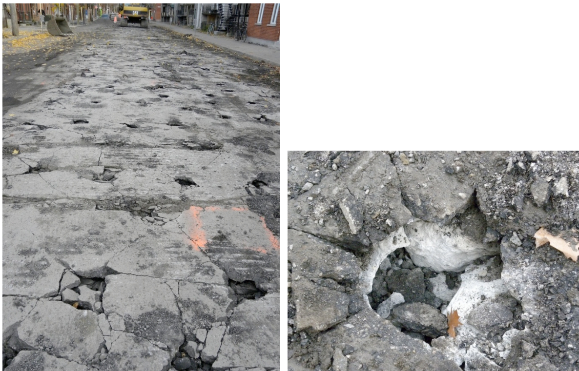
Figure 6-17: Photos de la surface cassée (à gauche: vue d'ensemble; à droite: vision spécifique de la dalle de béton cassée).
