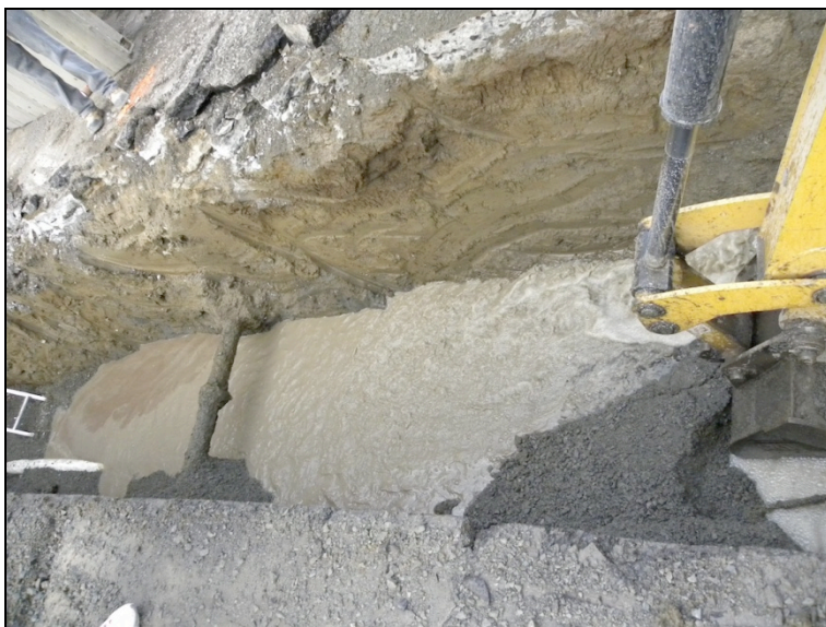
Figure 6-20: Conduite d'aqueduc percée lors de la coupe d'une tranchée.
