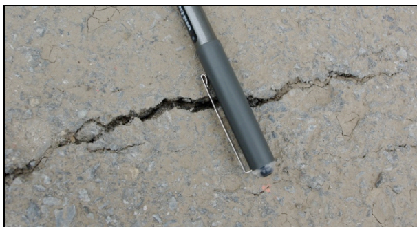
Figure 3-8: Fissure dans un béton de chaussée.
