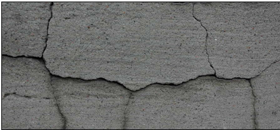
Figure 3-9: Écaillage transformé en fissure sur le haut de la photo et peu profond sur le bas.
