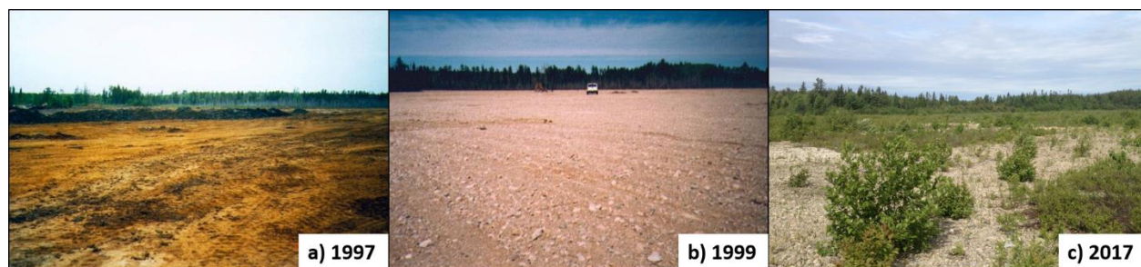
Figure 3.3 : Vue du site minier Lorraine a) avant les travaux de restauration en 1997; b) après la construction de la CEBC en 1999; c) avec la croissance de la végétation en 2017 (d'après Dagenais, 2005 et Bussière et al., 2009)
