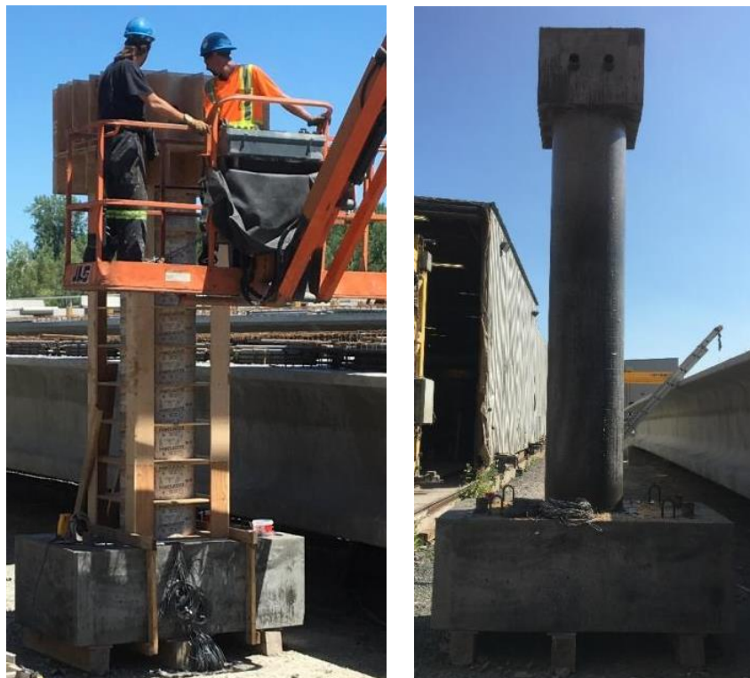
Figure 4-10 : Coulée de la colonne de référence
