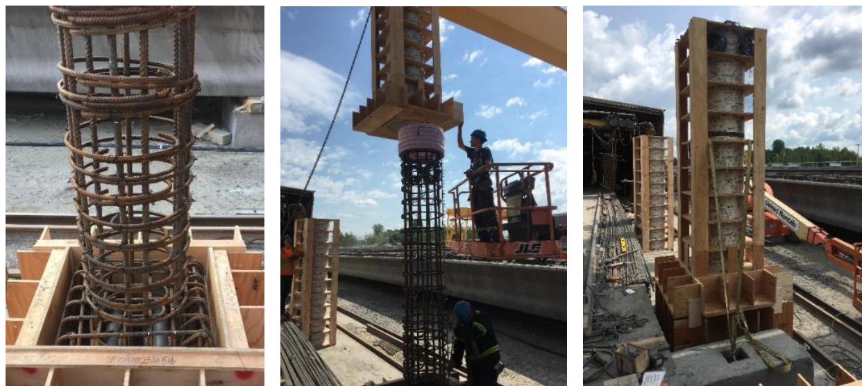
Figure 4-8 : Construction de la colonne préfabriquée
