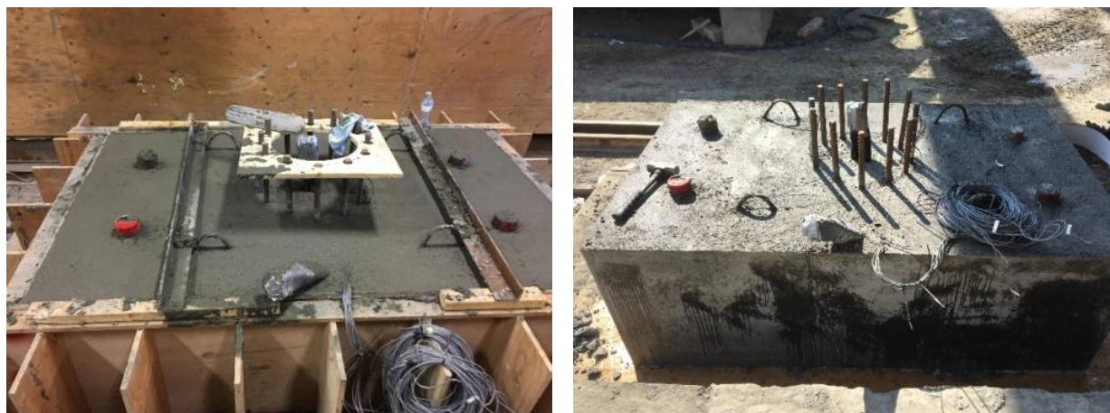
Figure 4-9 : Coulée de la semelle préfabriquée
