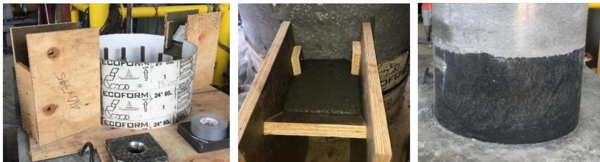
Figure 4-12 : Coffrage, coulée et résultat final du joint en BFUP
