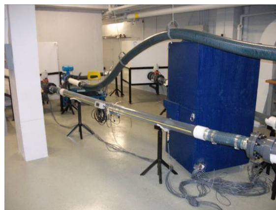
Figure 4-11 : Photo du modèle installé
