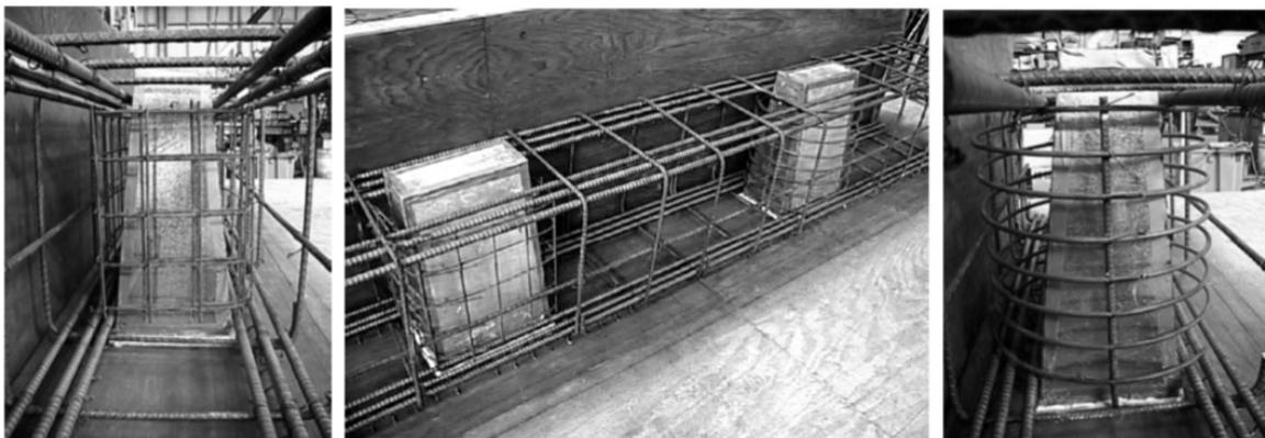
Figure 2.7 – Coffrages utilisés pour la préfabrication d'un chevêtre (Massicotte et al., 2011)
