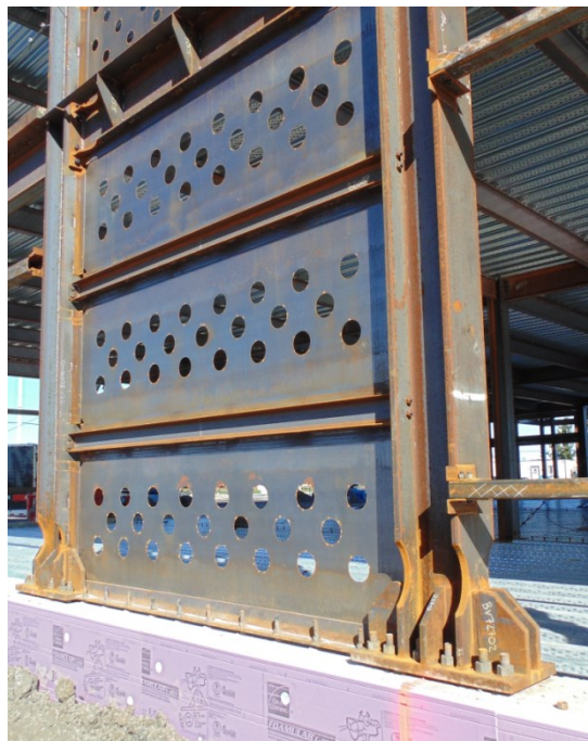
Figure 3.8 : Présence de deux (2) bielles entre l’ancrage du mur de refend aux fondations et la poutre du premier niveau, photo gracieuseté de Lainco.
