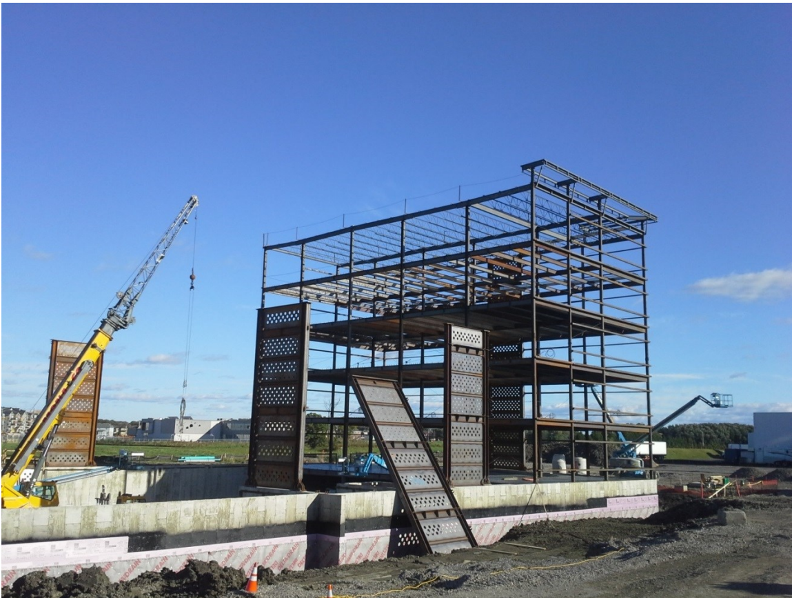
Figure 1.1 : Assemblage de segments de murs de refend au chantier. Photo gracieuseté de Lainco.
