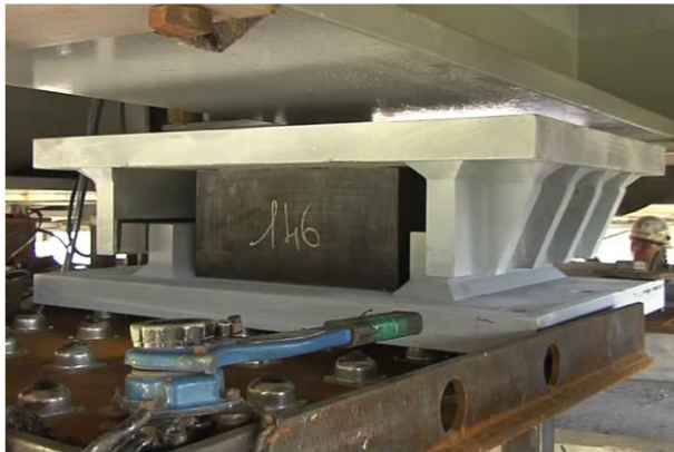
Figure 3.2: Isolateurs sismiques à noyau de plomb installés sur un pont : Avec système de guidage (à gauche); Sans système de guidage (à droite) (tiré de Mendez Galindo et al., 2015)
