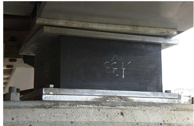
Figure 3.2: Isolateurs sismiques à noyau de plomb installés sur un pont : Avec système de guidage (à gauche); Sans système de guidage (à droite) (tiré de Mendez Galindo et al., 2015)
