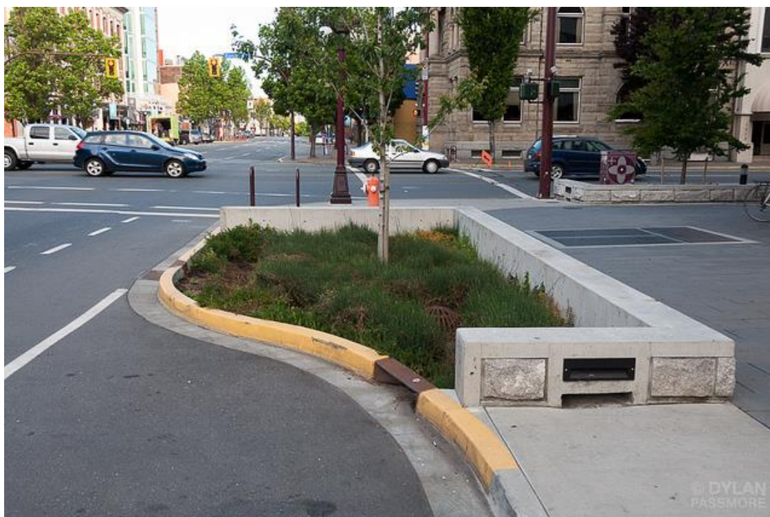
Figure A.3 : Saillie de trottoir avec biorétention, Victoria. Tiré de (LID SWM Planning and Design Guide contributors, 2018)
