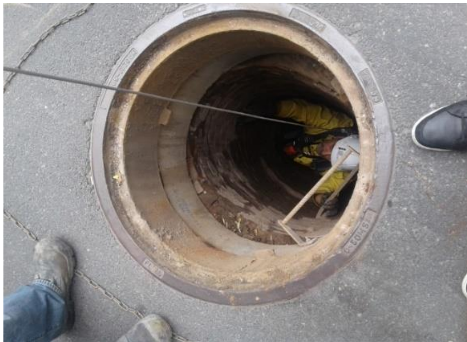
Figure 4.13: Regard d'accès pour l'installation des sondes débitmétriques (crédit photo : Daniel Kelvin Fezeu Nzeutcho et Inotes Simeon)
