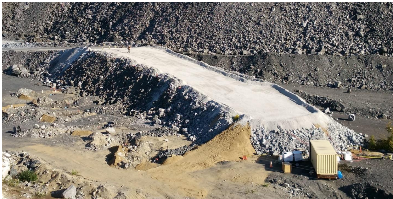
Figure 2.15 Halde expérimentale construite sur le site de la mine du Lac Tio (crédit: IRME); on y voit la rampe d'accès en arrière-plan, les bermes de protection de chaque côté (à la surface) et le conteneur (beige) qui contient divers équipements (à l'extrémité de la halde).
