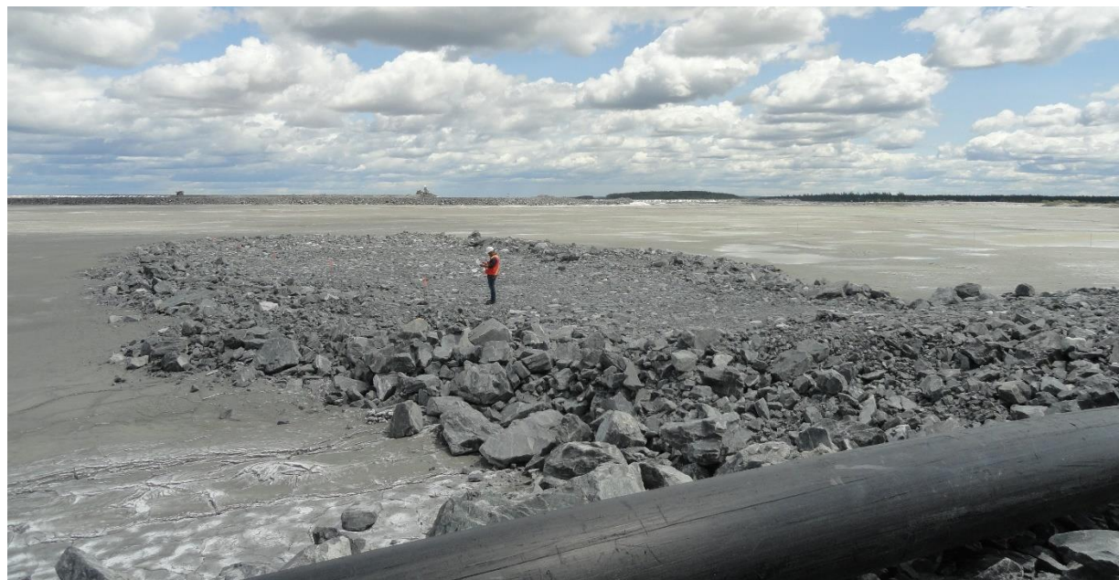
Figure 3.10: Photo de la voie d'accès en roches stériles sur le bassin de résidus minier PR1D à proximité de l'inclusion Digue Ouest.
