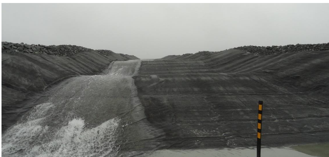
Figure 4.27: Photo du déversoir (environ 15 m de haut) du parc à résidus de la mine CM, situé dans la cellule de déposition PR2A.
