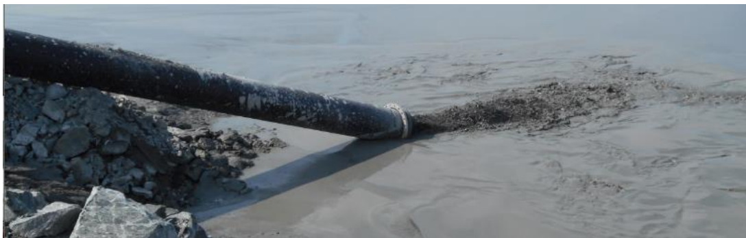
Figure 4.26: Déposition hydraulique des résidus miniers à partir de la crête de l'inclusion 1 dans la cellule de déposition PR1D du parc à résidus de la mine CM, septembre 2017.
