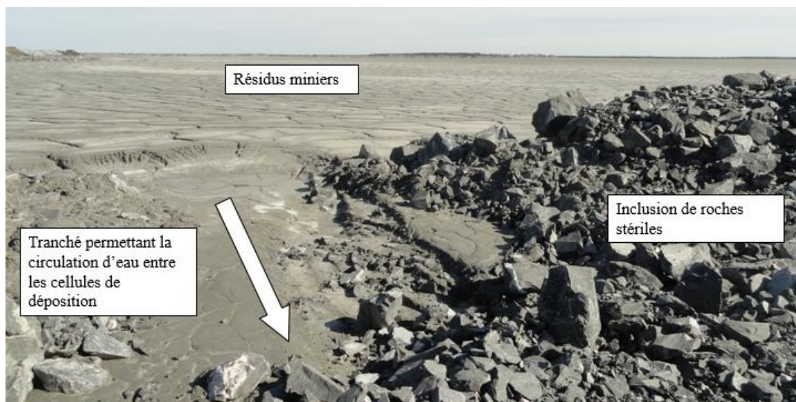
Figure 4.28: Déversoir temporaire pour évacuer l'eau de la cellule de déposition PR2B vers la cellule PR2A (parc à résidus de la mine CM, septembre 2017).
