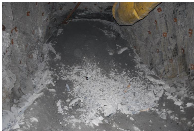
Figure 2-6: Barricade de stériles avant le placement de béton projeté (photo prise à la mine LaRonde dans le chantier 266-20-131B).
