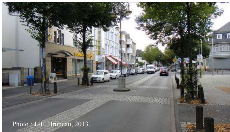
Figure 7.35 : Vue d'ensemble de la bande centrale polyvalente (Hennef, Allemagne)
