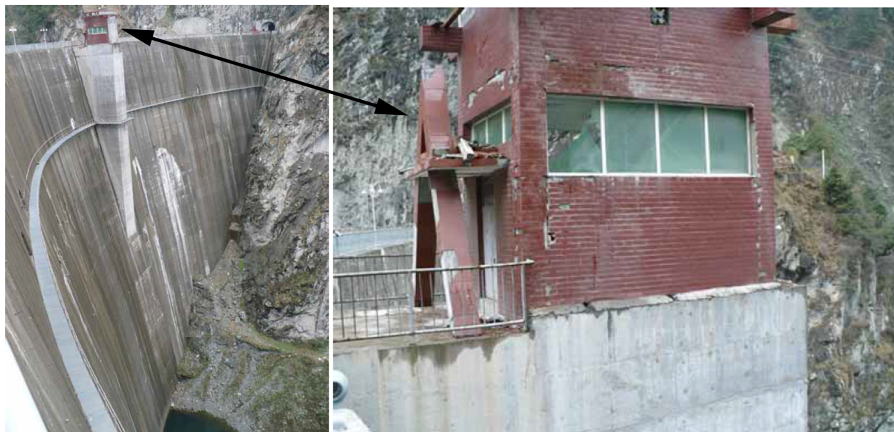
Figure 2.5 Endommagement du bâtiment de la cage d'ascenseur à la crête du barrage de Shapai pendant le séisme de Wechuan (Chine) de 2008, adaptée de (USSD, 2014)
