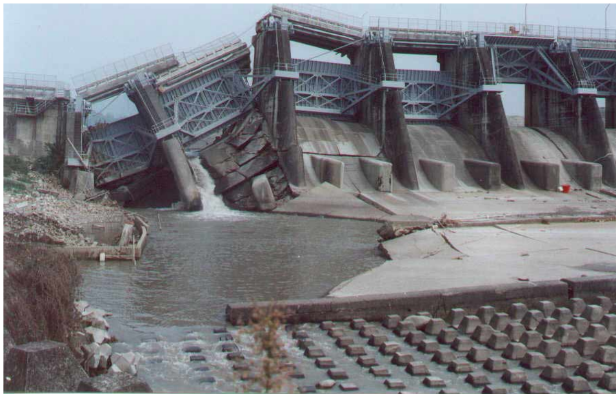
Figure 2.2 Effondrement du barrage de Shih-Kang pendant le séisme de Chi-Chi de 1999 en Taïwan (Wieland and Fan, 2004)
