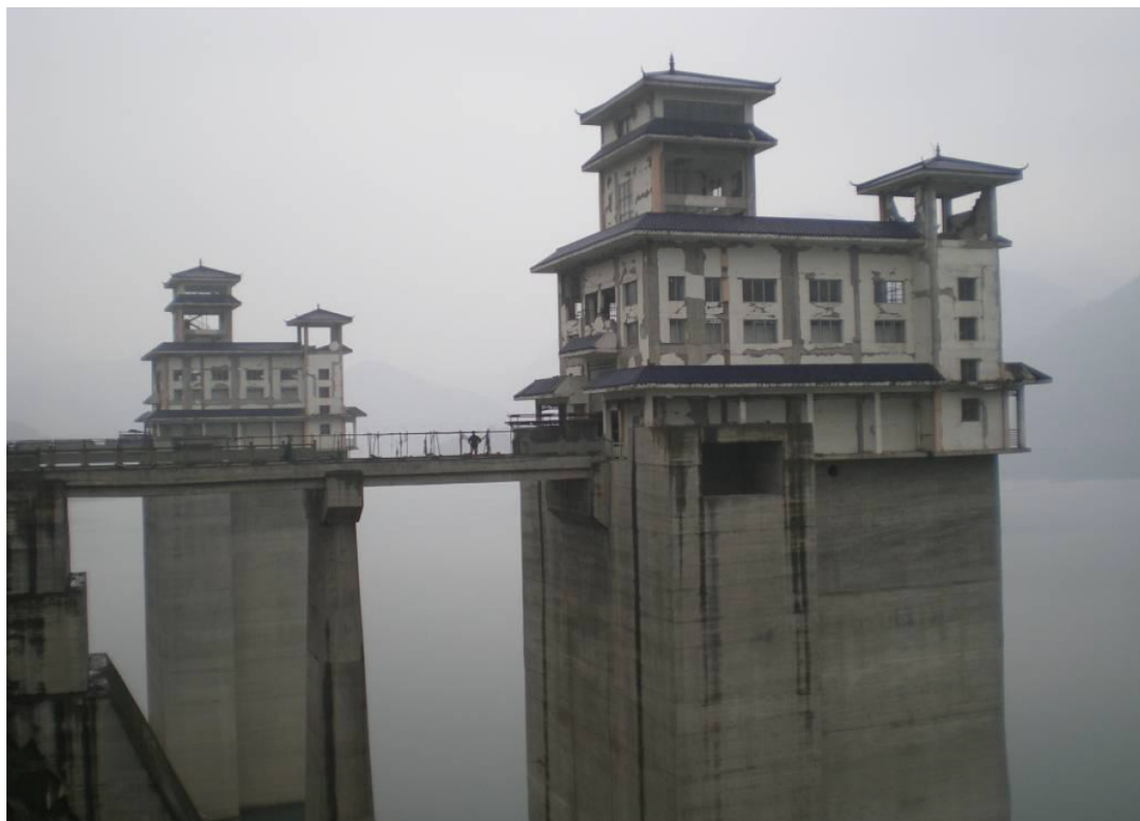
Figure 2.4 Endommagement d'un bâtiment en béton sur la tour de prise d'eau du barrage de Zipingpu pendant le séisme de Wechuan (Chine) de 2008 (ICOLD, 2012)
