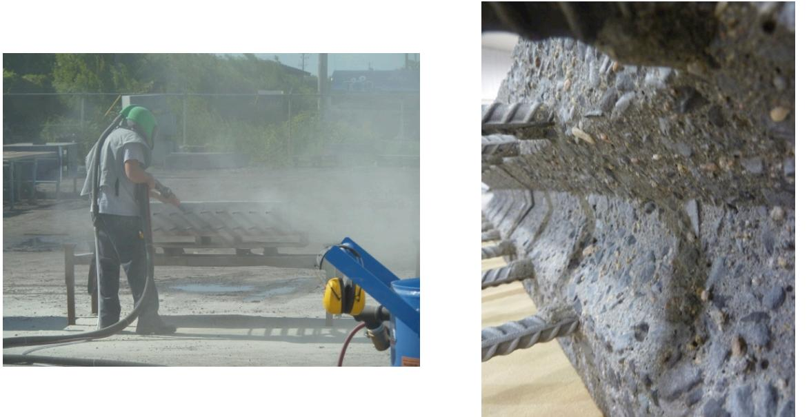
**a) Réalisation****b) Résultat de la dalle 19 (3o-U-Q-1-S)****Figure 3-10 : Abrasion au jet de sable**
