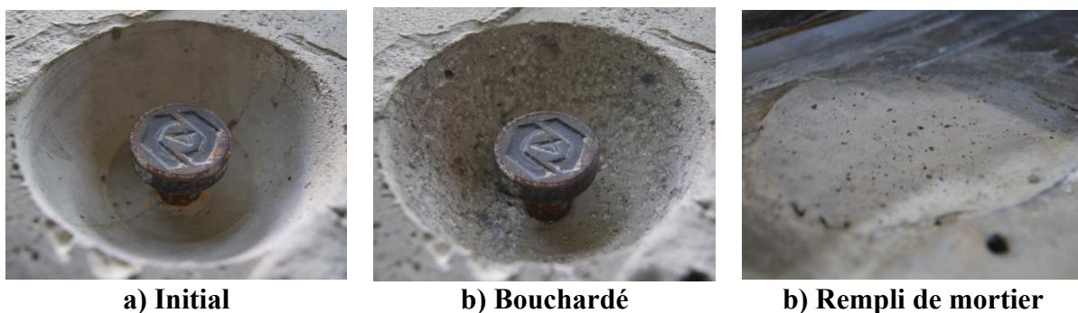
**Figure 3-18 : Creux des clous de levage**
