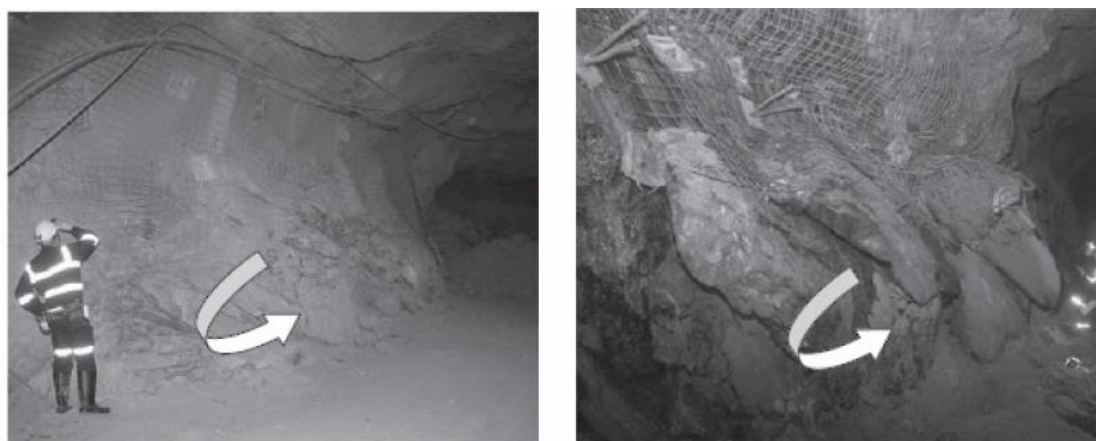
Figure 5-9: Exemple de flambage et de rotation majeurs de la foliation d'une excavation à la mine Laronde sous l'effet d'un terrain poussant (Potvin et Hadjigeorgiou, 2008).
