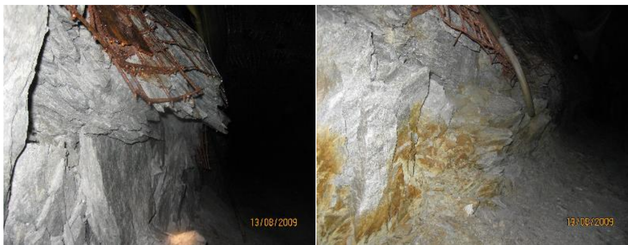
Figure 5-8 : Glissement et rotation des plans de schistosité à l'éponte inférieure à la mine Westwood dans un terrain poussant (Armatys et Berson, 2009).
