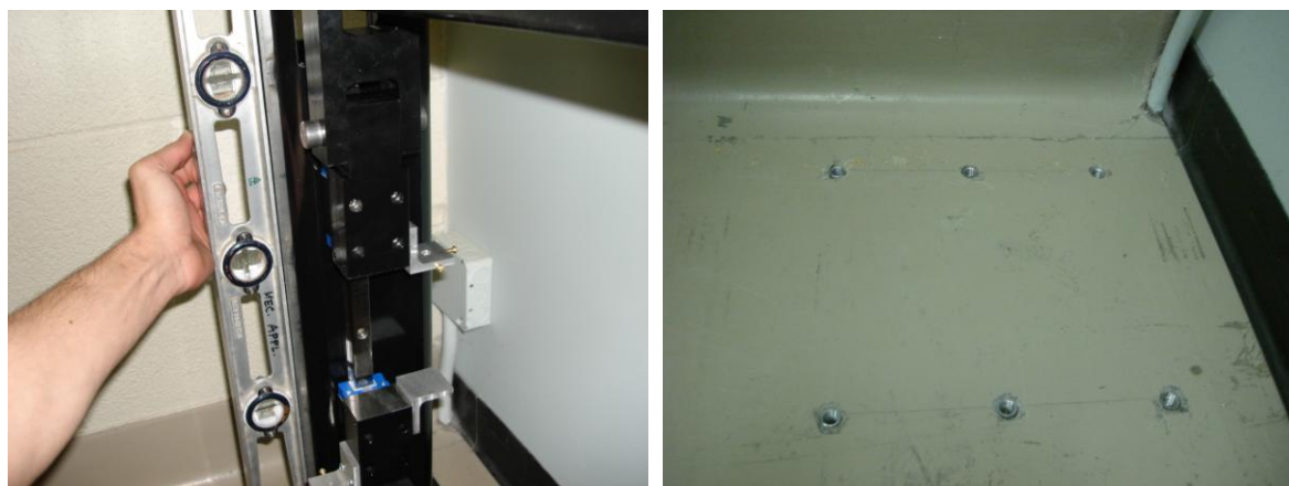
Figure 3.8 Photos de l'installation du poteau vertical dans le sol. (a) Le poteau a été installé à l'aide d'un niveau afin de garantir la verticalité. (b) Le poteau est solidement fixé dans le sol avec des chevilles en acier installées dans le béton.
