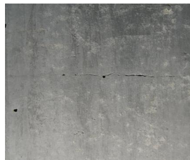
c) Fissure horizontale face Est
