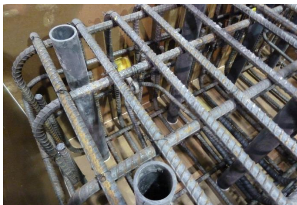
a) Ancrage des tuyaux au fond du coffrage
