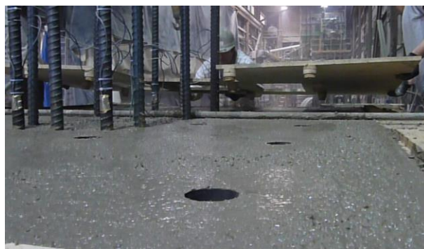
b) Mise en place du gabarit suite à la coulée
