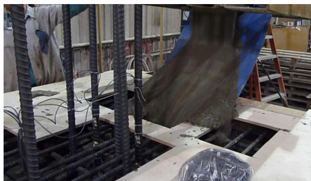
a) Déversement d'une gâchée dans le coffrage
