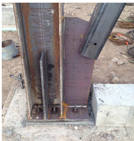
Figure 1.3 : Plaque de base et ancrages d'une colonne de contreventement en chantier
