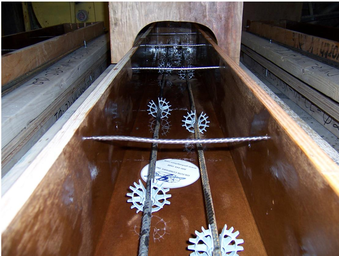
**Figure 4.5 : Intérieur d'un coffrage pour poutre hyperstatique avant la coulée**
