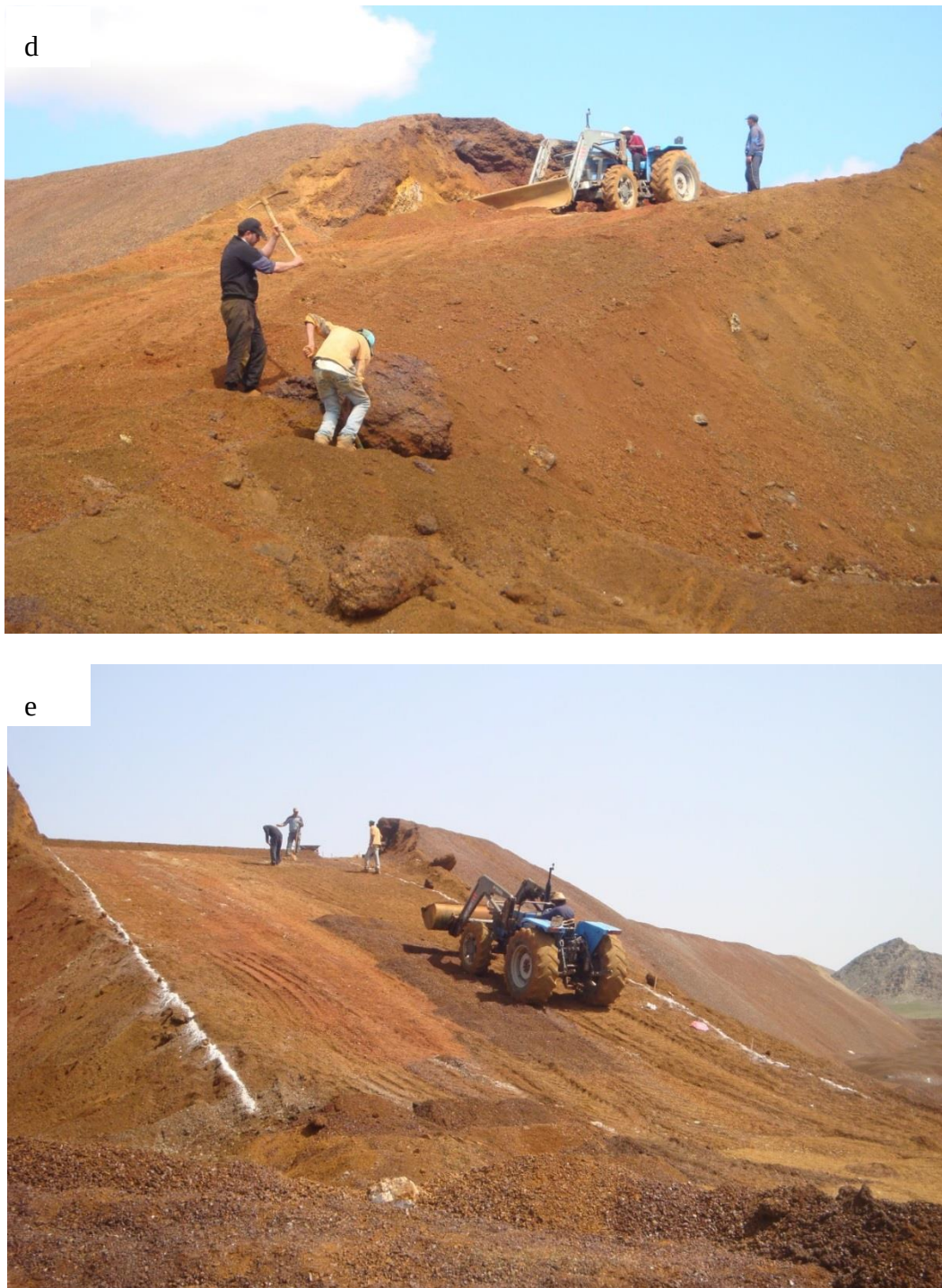
Figure C.2 : Travaux d'aplanissement de la pente (a, b, c, d, e)
