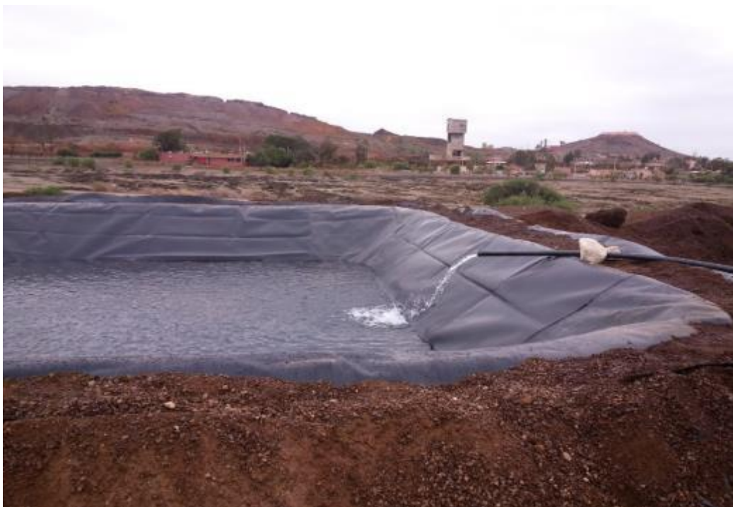
Figure F.1 : Construction du bassin d'eau pour l'irrigation
