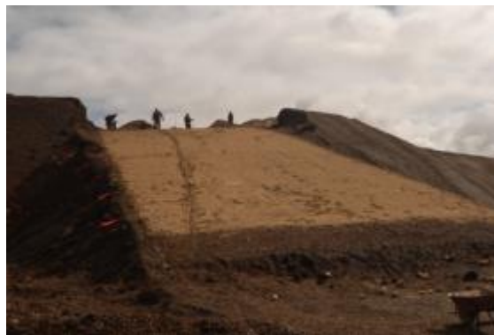
Figure 3.16 : Événement de pluie lors de la mise en place de la couche SR
