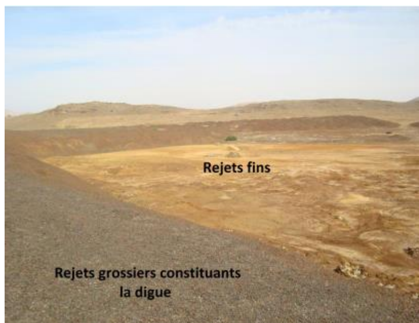
Figure 3.2 : Rejets à granulométrie grossière posés de manière à retenir les résidus fins
