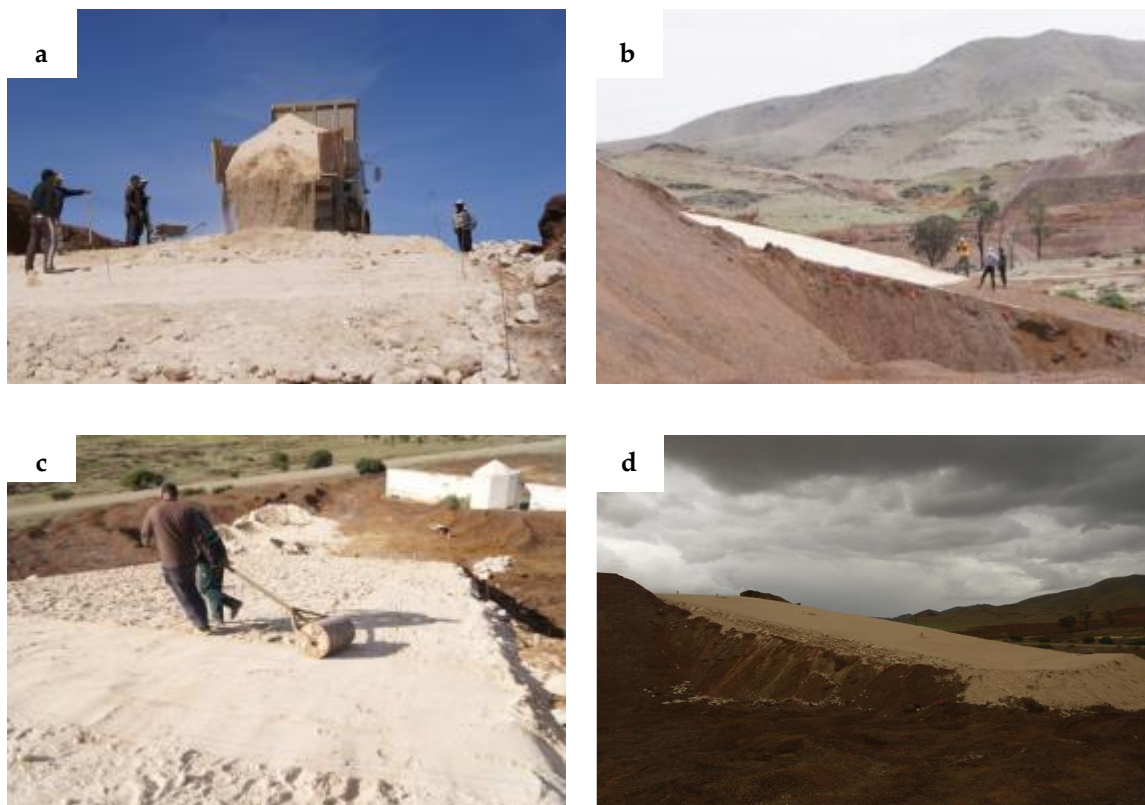
Figure 3.15 : Mise en place et compactage de la couche calcaire phosphatée (a et b) mise en place des rejets calcaires phosphatés (c) compactage manuel des rejets calcaires phosphatés (d) vue de la cellule inclinée après la mise en place de la couche de rejets phosphatés
