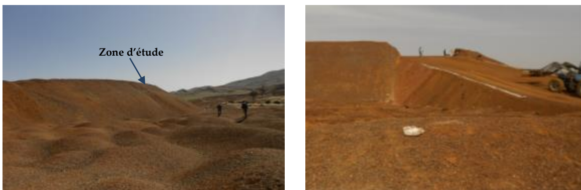
Figure 3.13 : Nivellement de la digue
