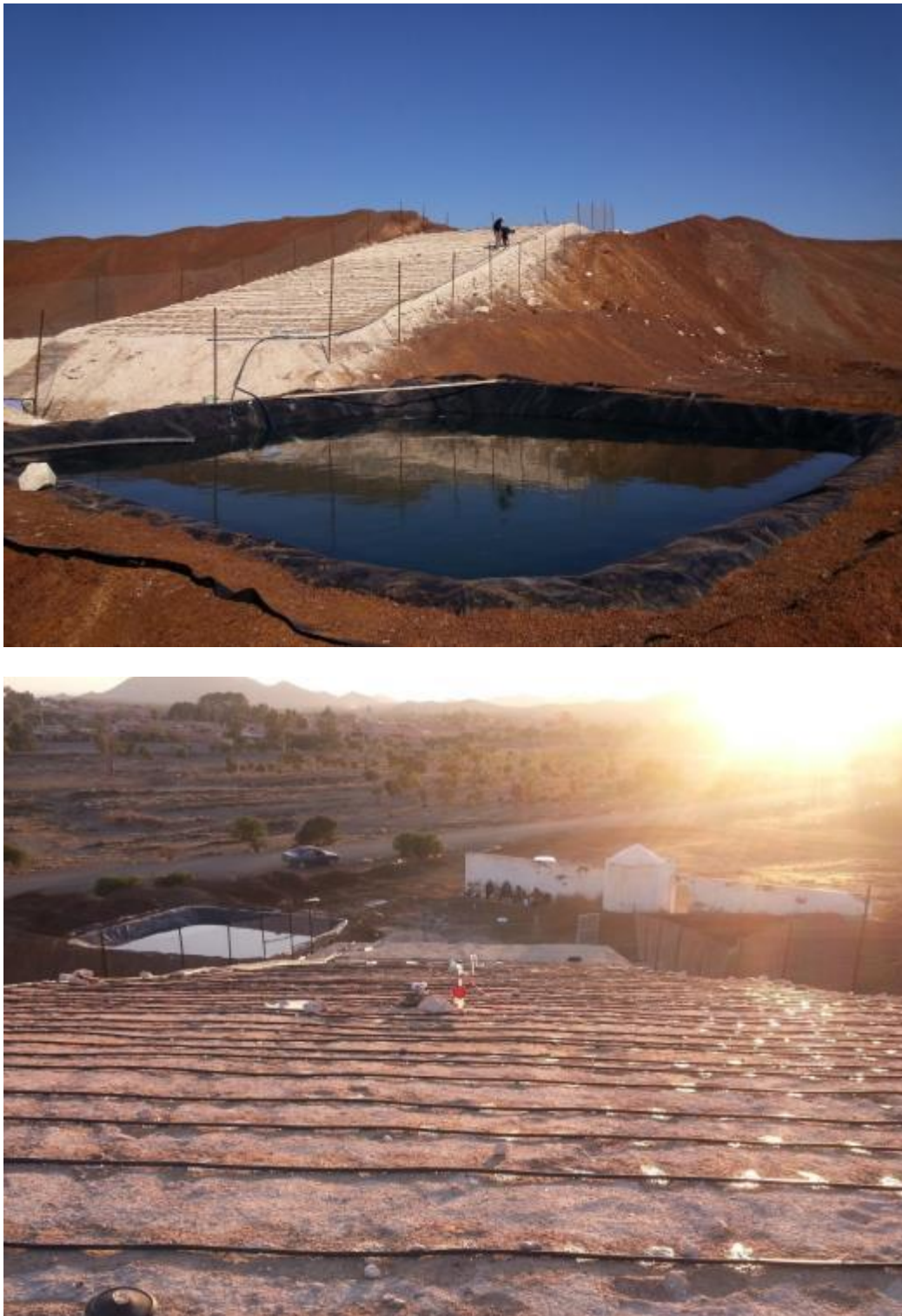
Figure F.3 : Démarrage des travaux d'irrigation
