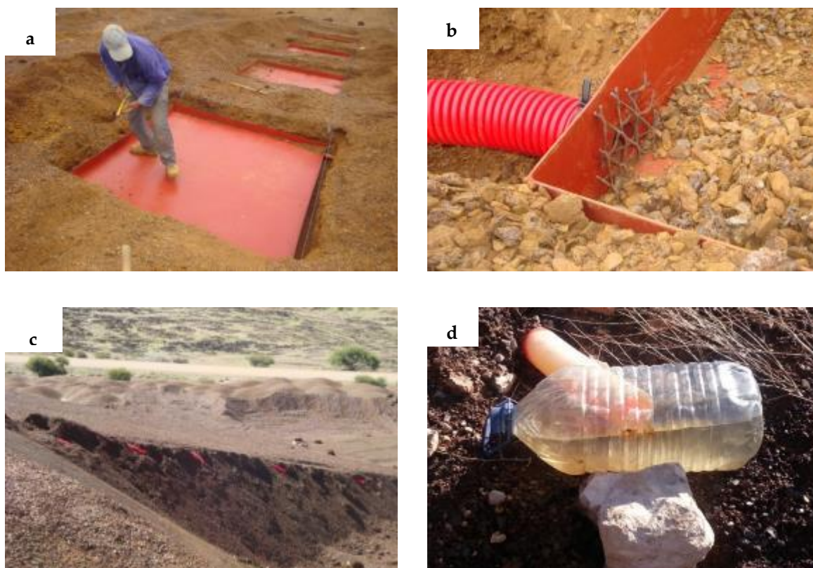
Figure 3.14 : Mise en place des lysimètres (a), collecte des eaux de percolation (b, c et d),
