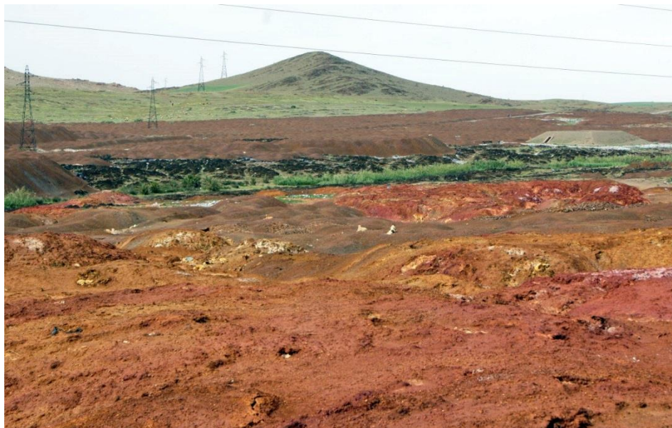
Figure B.4 : Rejets fins entourés par la digue
