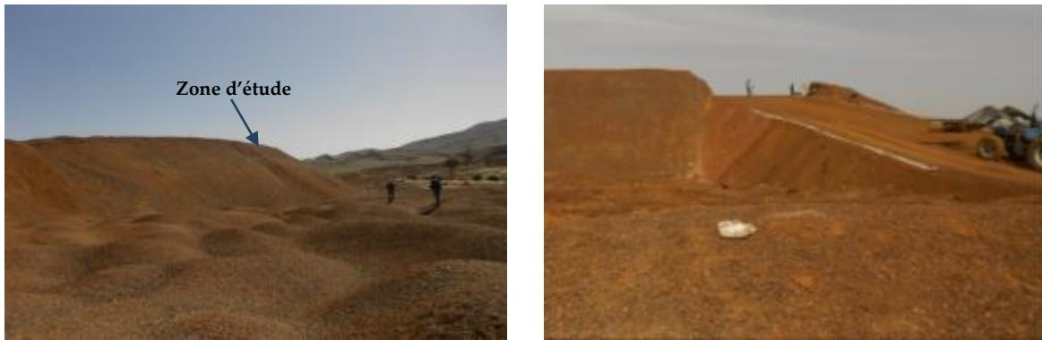
Figure 3.13 : Nivellement de la digue
