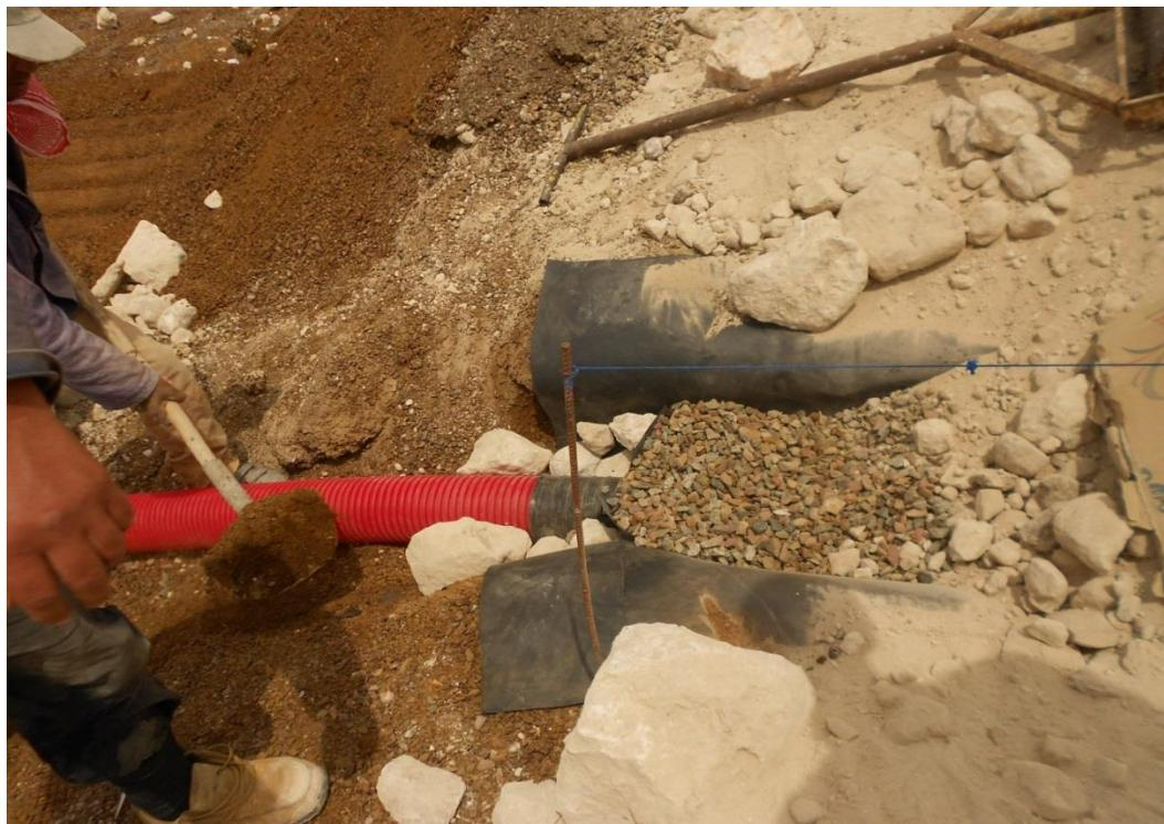
Figure C.5: Drain sous forme de géomembrane relié à un tuyau
