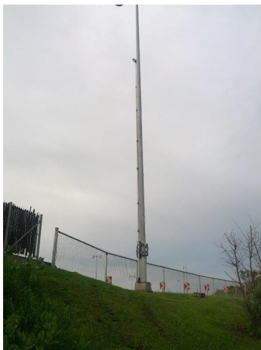
Figure 3-7 : Installation du système de collecte vidéo sur un fût d'éclairage du Ministère des Transports du Québec aux abords de l'Autoroute A20 dans l'Ouest de l'île de Montréal
