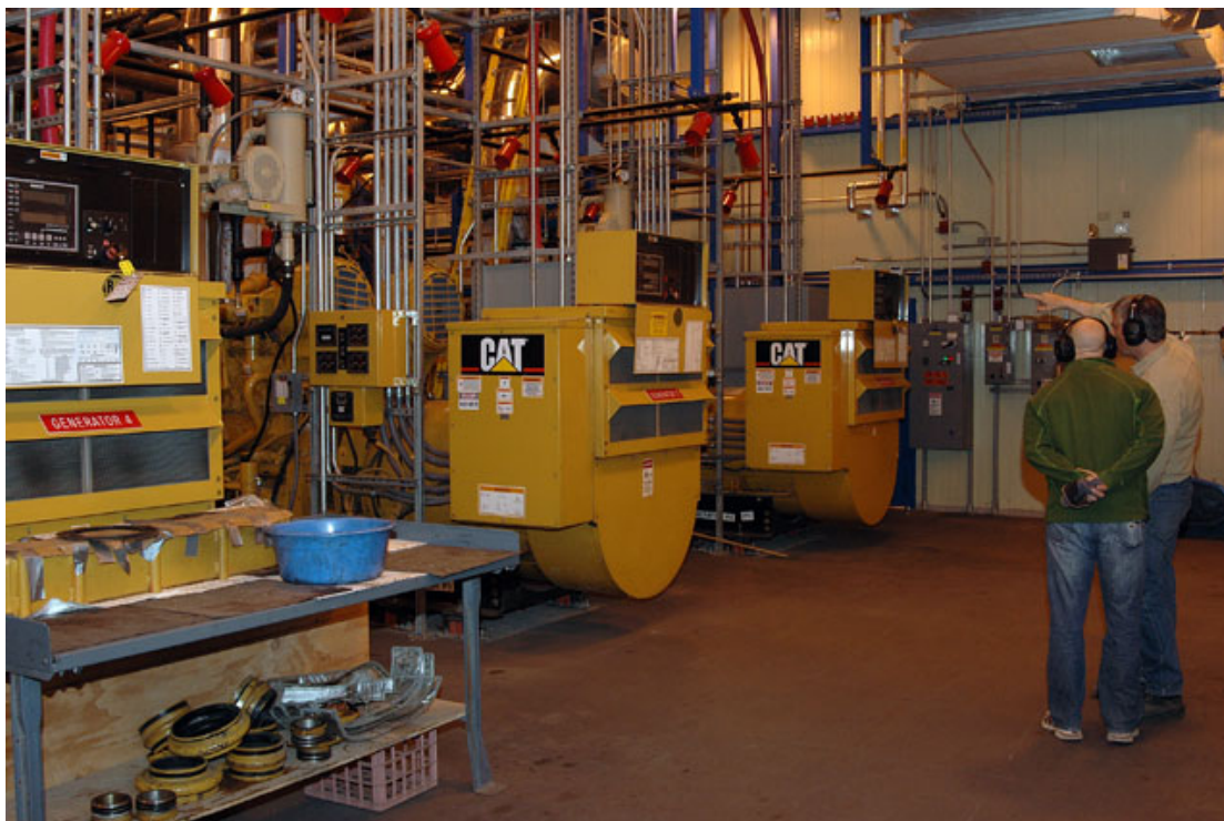
Figure 1.2 Centrale composée de génératrices diesel à la base de McMurdo © The Antarctic Sun, US National Science Foundation, Rejcek (2011)
