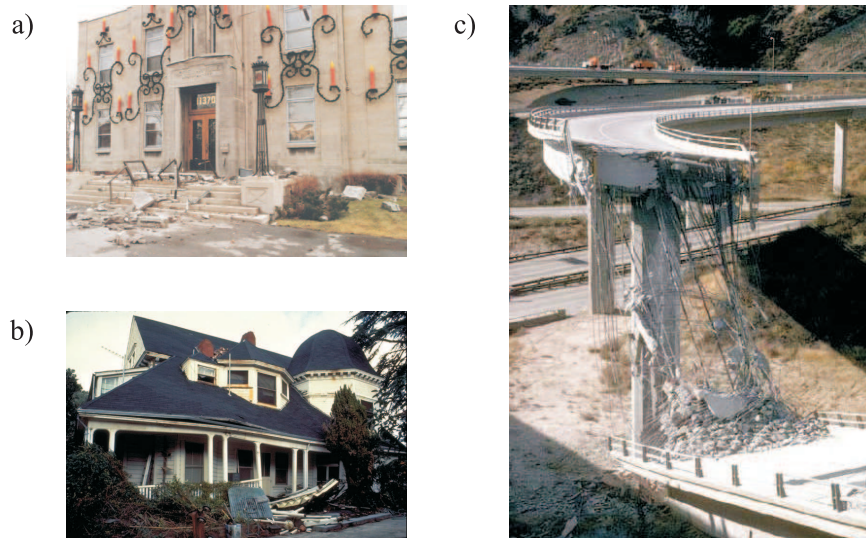
FIG. 2.8 : Dégâts de quelques séismes historiques. (a) Mairie de Montréal Est (Saguenay) [Ressources Naturelles Canada 2009]. (b) Condo de Los Gatos (Loma Prieta) [Martin and Associates 2009]. (c) Échangeur proche de l'épicentre de Northridge [USGS 2009].
