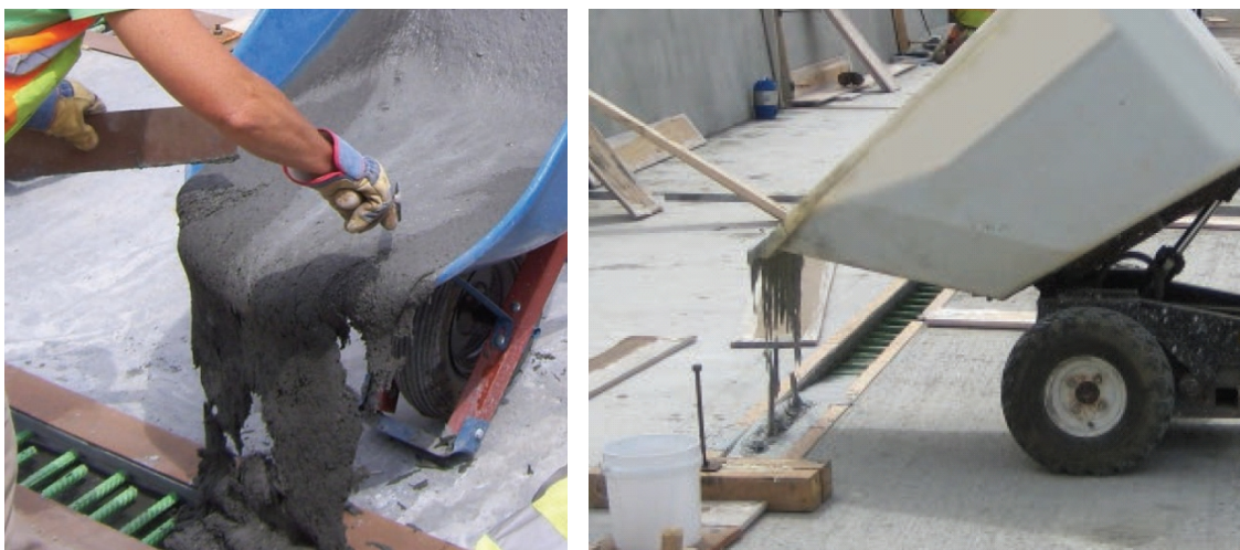
Figure 9.1 : Phase de coulage sur chantier de joint de dalles de pont préfabriquées avec du BFUP (Graybeal 2014)
