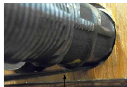
Cale d'ajustement en acier de 0.2 mm pour garantir l'horizontalité de chaque barre
