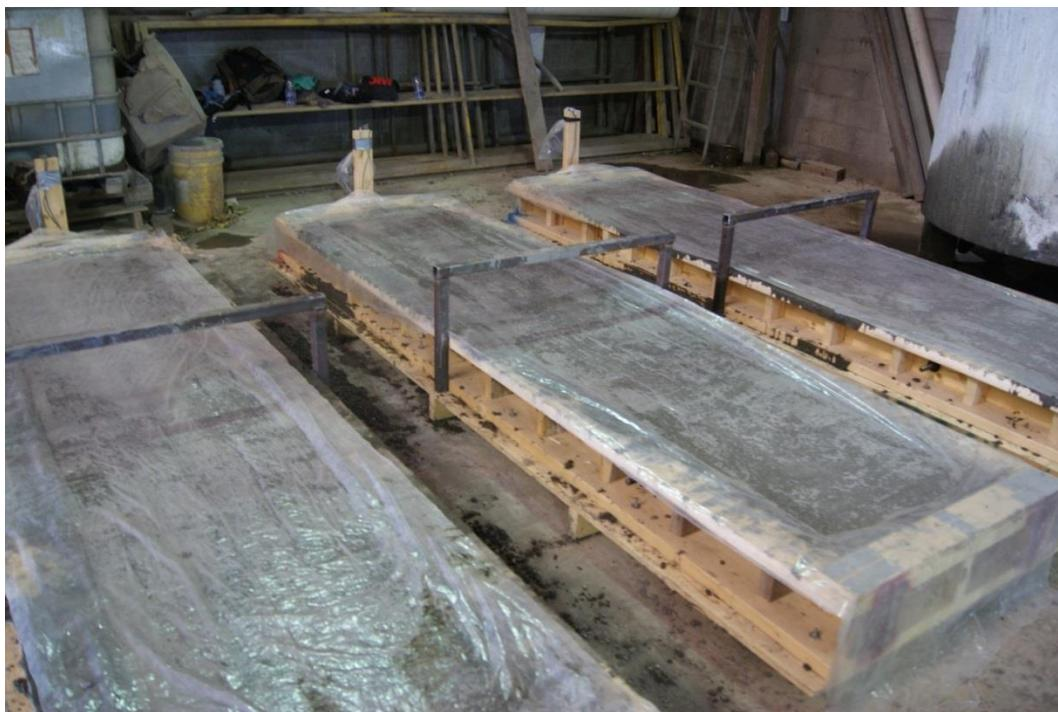
**Figure D-4 : Film de polyéthylène placé sur les dalles**
