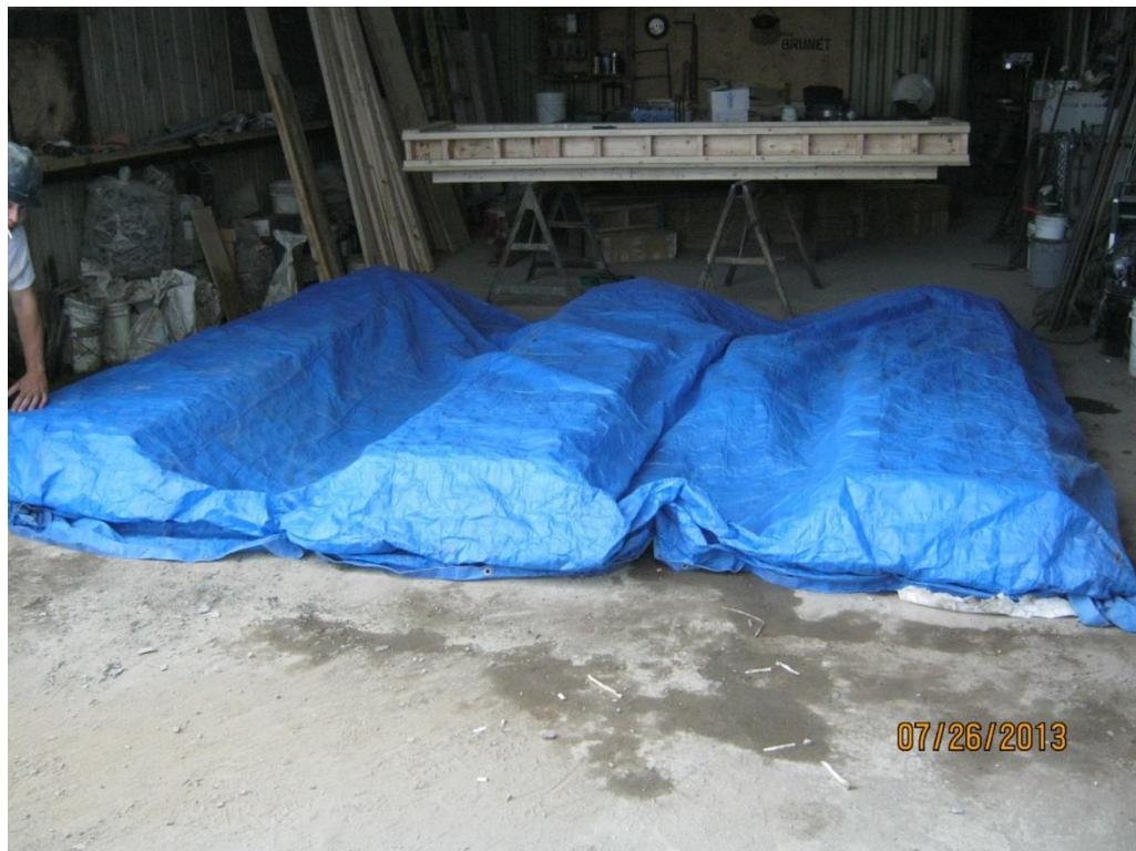
**Figure D-6 : Bâche installée par-dessus les dalles et la membrane de cure**
