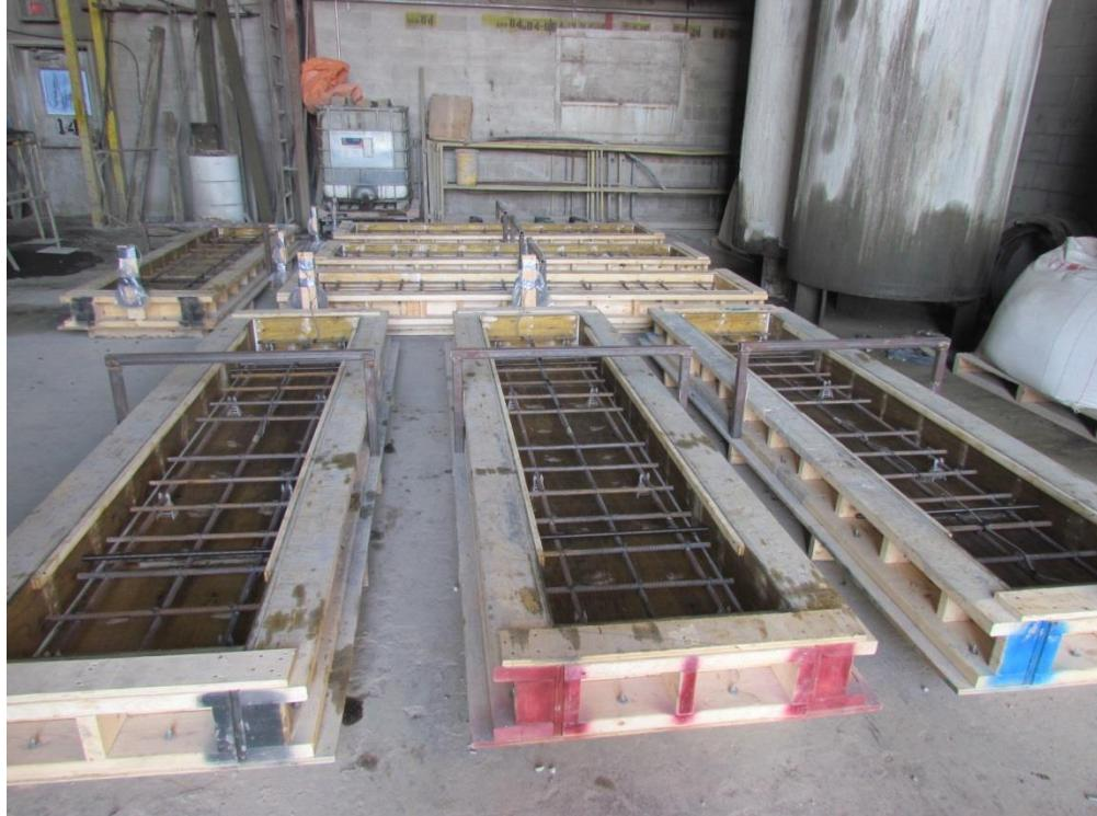
**Figure 3-10: Disposition des coffrages avant la coulée de la 2<sup>e</sup> journée de fabrication**
