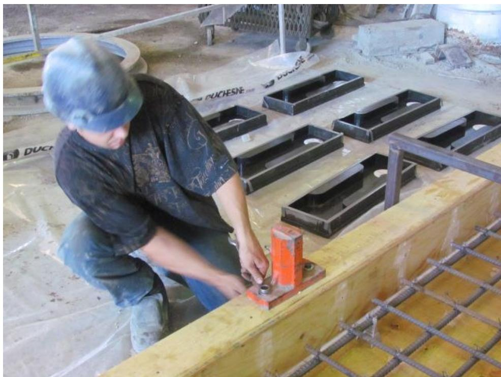
**Figure D-2 : Installation de vibrateurs externes sur les coffrages**
