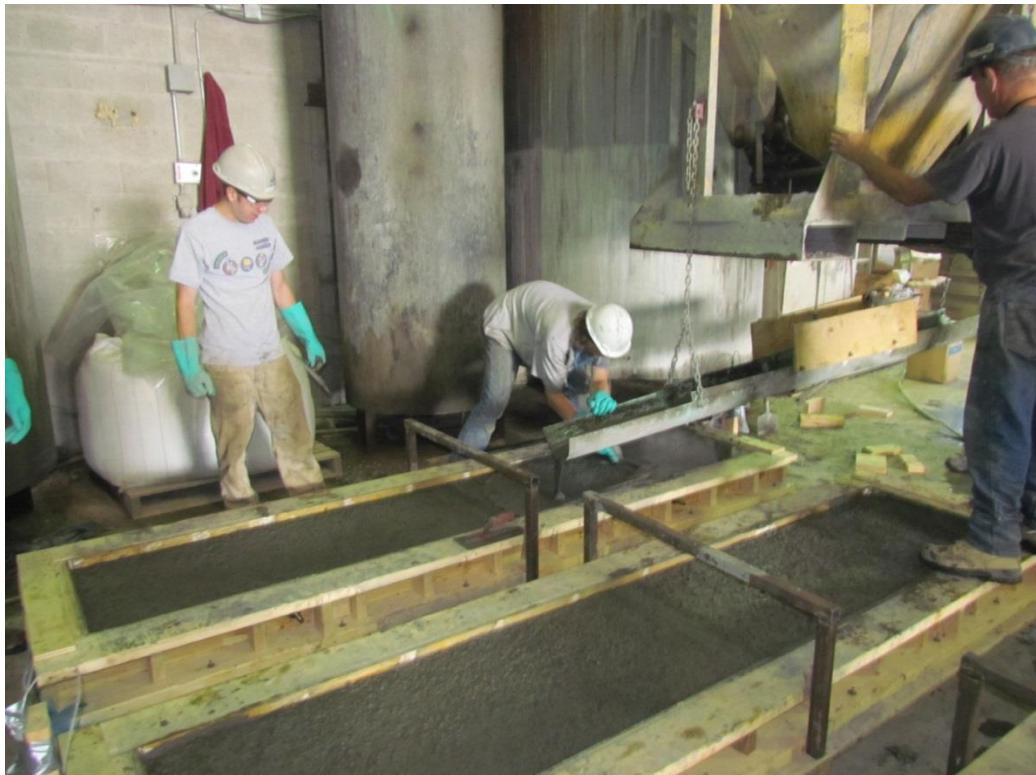
**Figure D-9 : Mise en place du BFUP pour les dalles hybrides**
