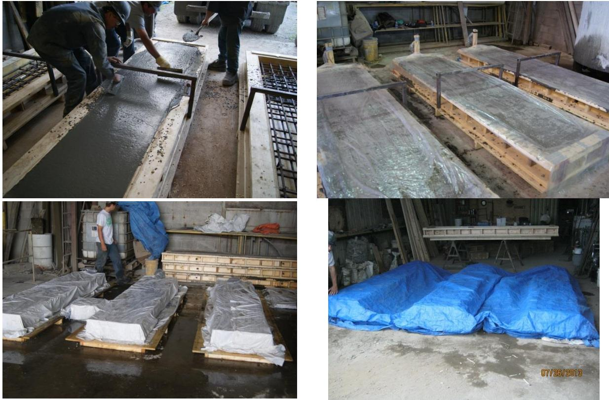
**Figure 3-12: Finition (en haut) et cure (en bas) des dalles**
