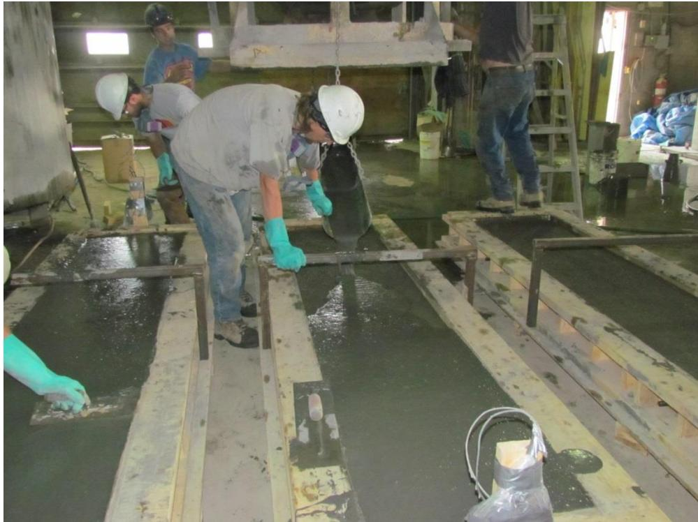
**Figure 3-11: Mise en place du BFUP pour les dalles hybrides**
