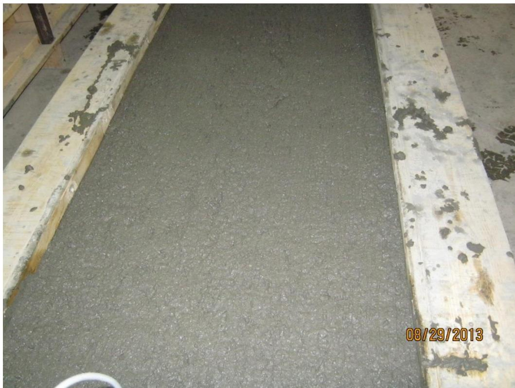
**Figure D-8 : Finition du BFHP50 de la dalle hybride à la truelle à céramique**
