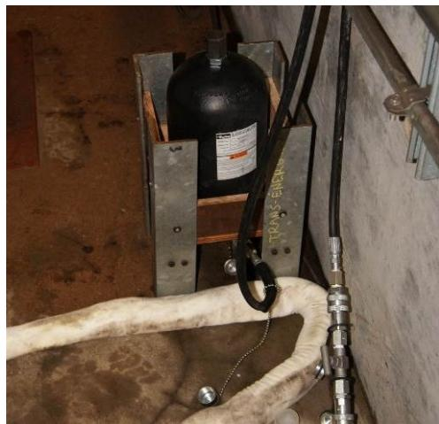
3. Accumulateur Parker 6600 psi et valve hydraulique VH1
