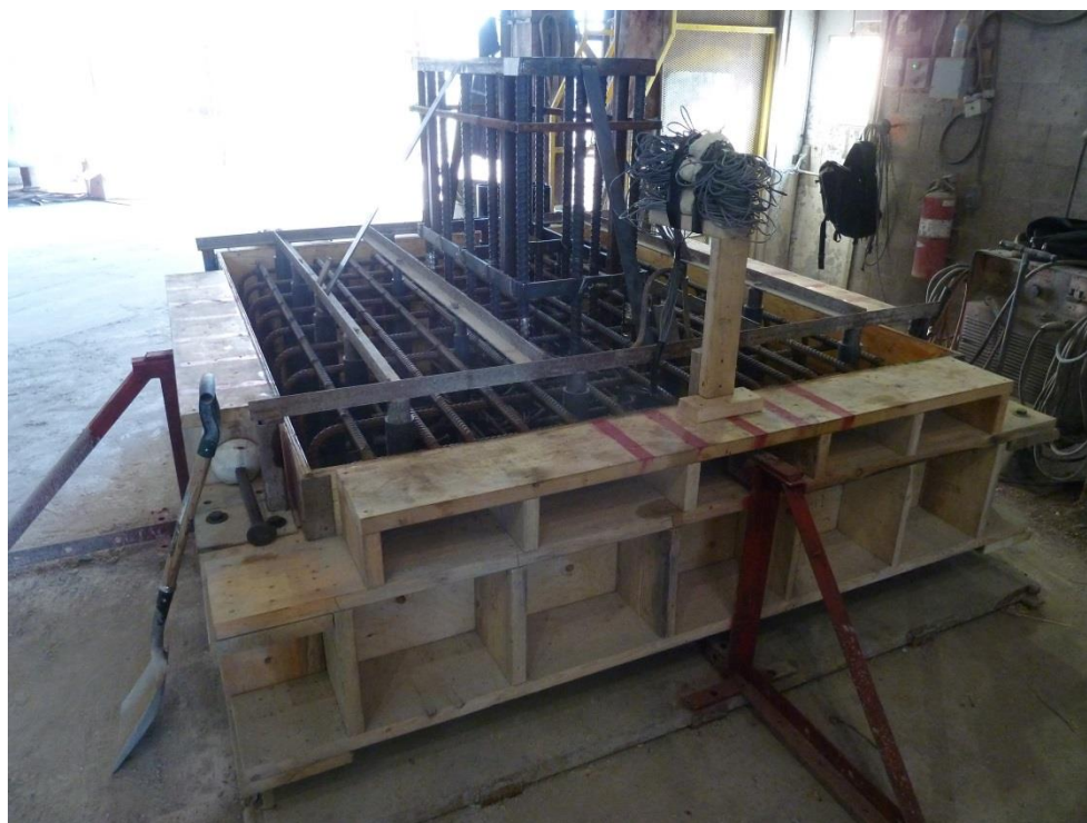
Photo 7 : Mise en place du support pour assurer la verticalité des tubes de PVC (8 août)
