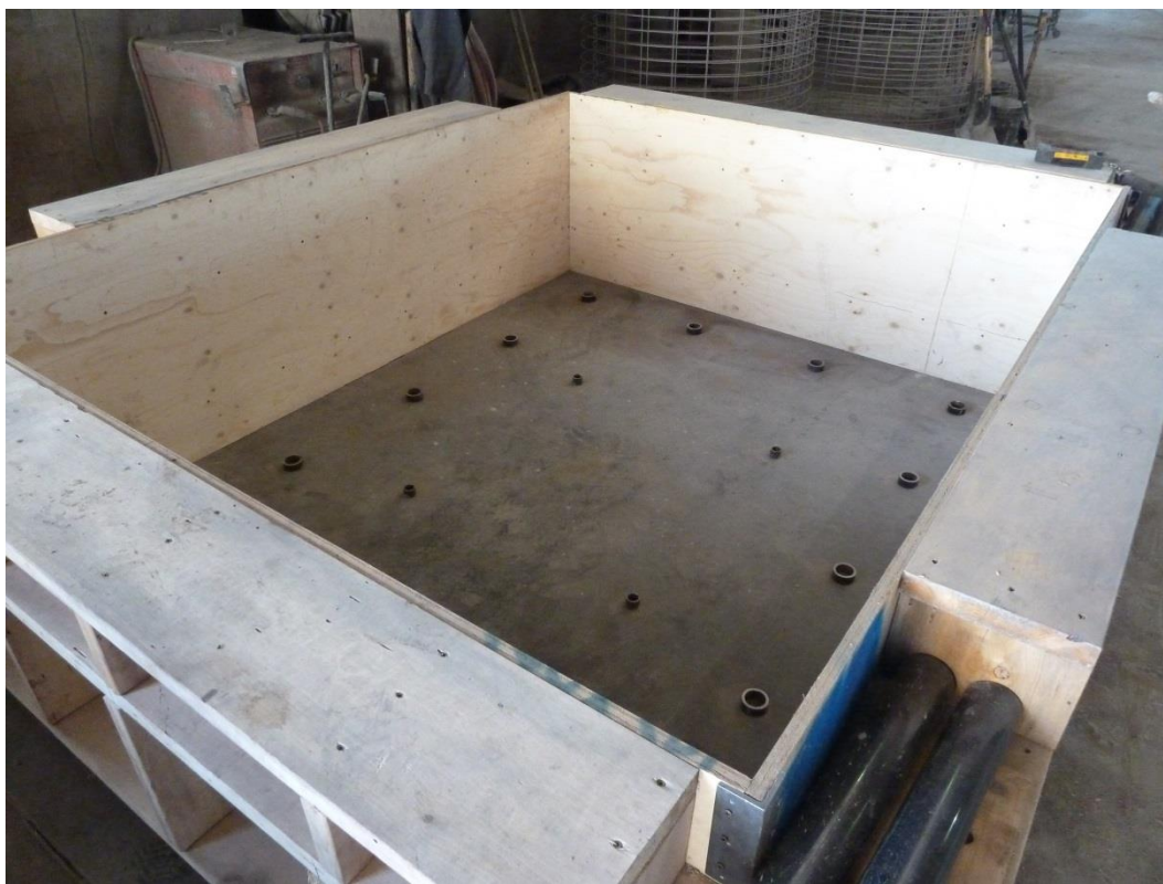
Photo 1 : Positionnement des rondelles d'acier dans le fond du coffrage (30 juil.)
