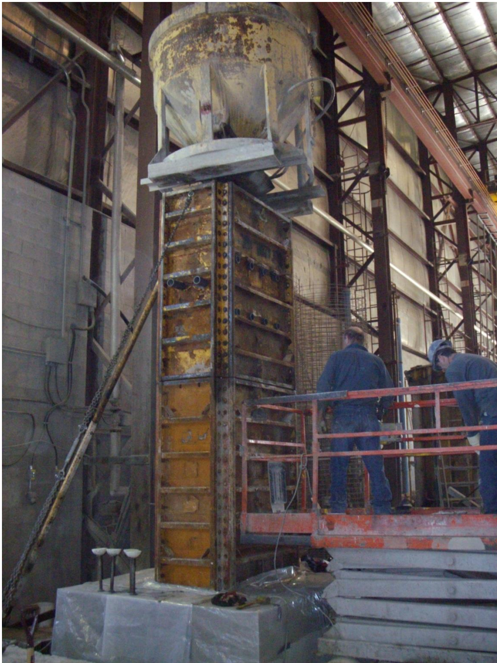
Photo 2 : Coulée de la pile S5 (17 sept.)
