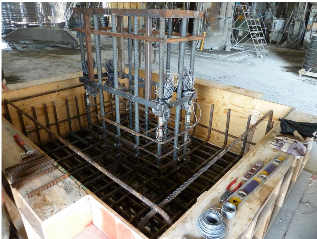
Photo 5 : Mise en place des barres jaugées dans la cage de la semelle S5 (7 août)
